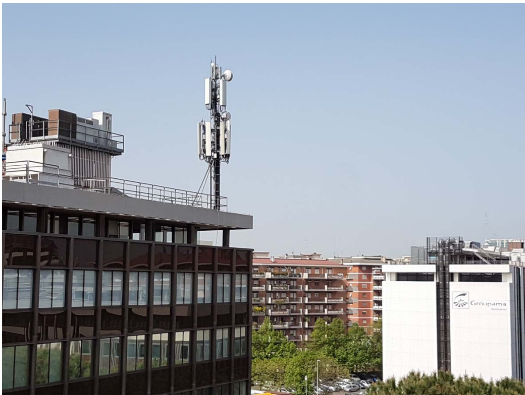
Foto: impianto SRB oggetto di indagine
