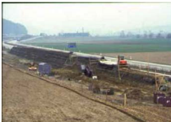
Foto 71 – Barriera antirumore in terra rinforzata verde in rete sintetica con talee di salice (Svizzera anni '80). Foto G. Sauli
