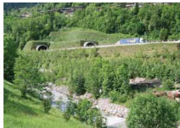
Foto 62 - idem dopo 18 anni. Si noti la crescita rigogliosa di arbusti ed alti arbusti che maschera completamente la struttura (Foto G. Sauli 2006)
