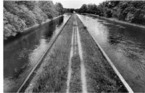
Piste ciclabili su Canale Villoresi foto di G. Berengo Gardin
