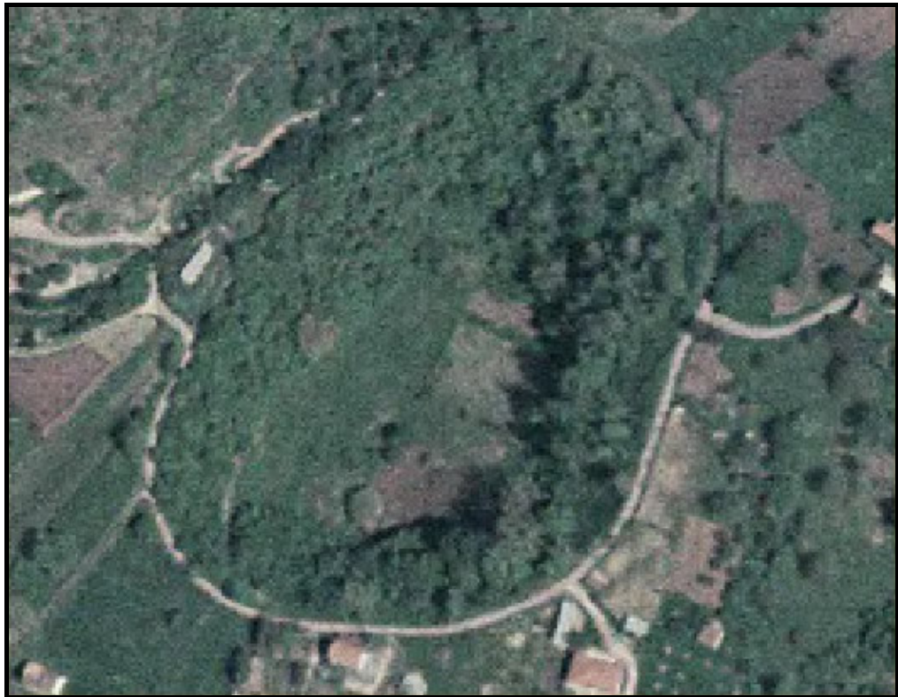
Fig. 31 – Ortofoto a colori dello sprofondamento di Fossato di Raio.
