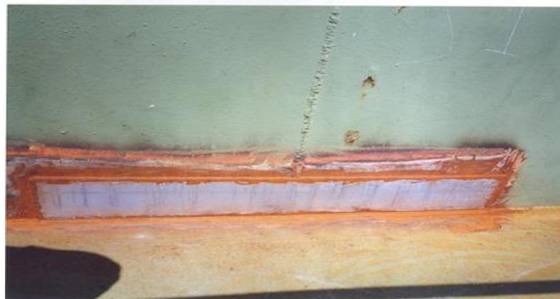
MANTELLO: 8ª VIBOLA; RIPRISTINO DELL'AREA CORROSA DI CUI SOPRA DESCRITTA, MEDIANTE L'APPLICAZIONE DI LAMIERA SALDATA.
