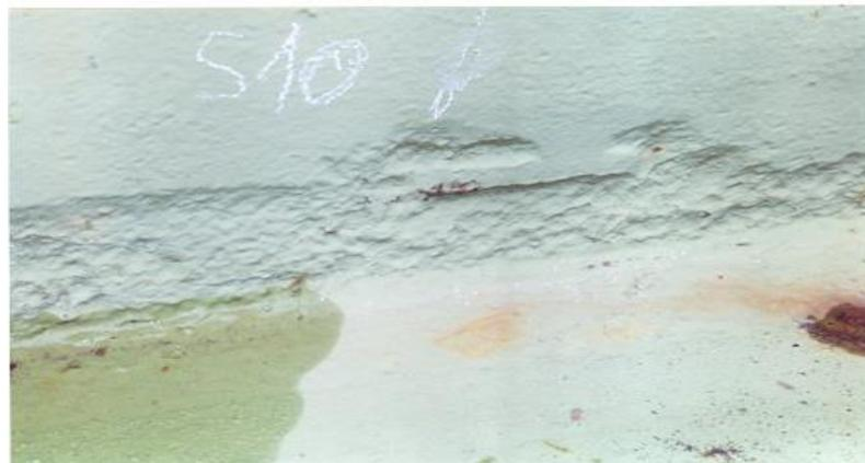
MANTELLO: 8ª VIBOLA; AREA DI CORROSIONE NON ATTIVA, DI PROFONDITÀ 4-6 mm LOCALIZZATA SU UNA FASCIA (DI H. ~ 150 mm E LUNGH. ~ 1200 mm) A RIDOSSO DELLA SALDATURA CIRCONFERENZIALE DI ATTACCO DELLA PASSERELLA DI SOMMITÀ CON LA LAMIERA DEL MANTELLO.
