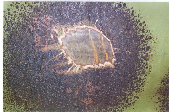
MANTELLO 1<sup>A</sup> VIROLA: RIPRISTINO SUL MANTELLO MEDIANTE RIPORTI DI SALDATURA
