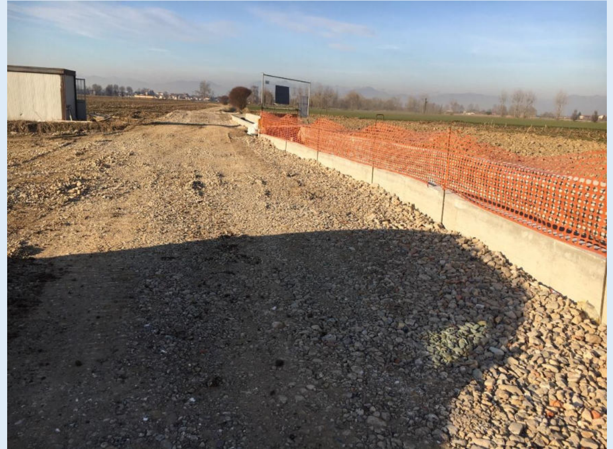
Aggregato artificiale utilizzato come massicciata stradale
