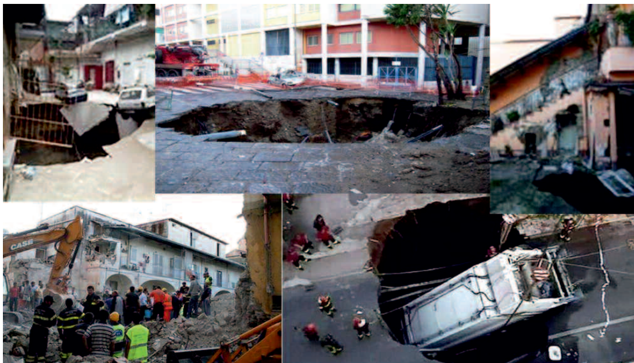
Fig. 7 – Immagini relative ad alcuni dei principali sinkholes verificatisi nell'ultima decade, riportati in tab. 3. - Some of main sinkhole phenomena occurred during last decade (see tab. 3).
