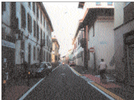
Figura 4 - Recupero di una strada urbana a Cuggiono. Fonte: G1 srl Novara
