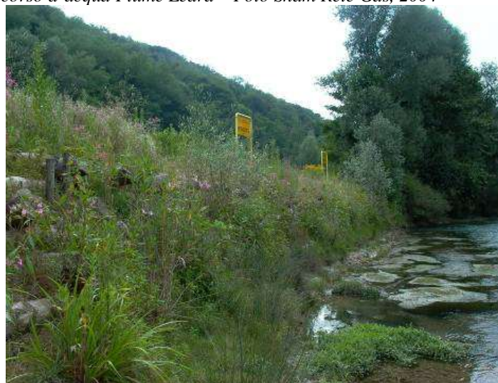
Foto 115 - Metanodoto Bordano – Flaibano (UD), palificata spondale in legname e pietrame realizzata per il ripristino spondale del corso d'acqua Fiume Ledra dopo 2 anni – Foto Snam Rete Gas
