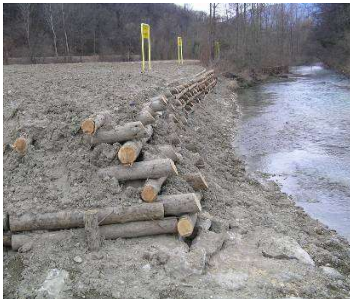
Foto 114 - Metanodoto Bordano – Flaibano (UD), palificata spondale in legname e pietrame realizzata per il ripristino spondale del corso d'acqua Fiume Ledra – Foto Snam Rete Gas, 2004
