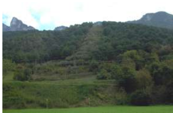
Foto 17 - Metanodotto Malborghetto – Bordano (UD) vista frontale interventi - Foto Snam Rete Gas, 2009
