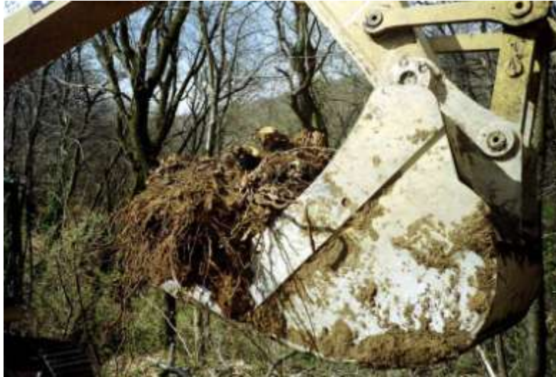
Foto 103 – Trapianto Castagno in Regione Piemonte – Foto Snam Rete Gas
