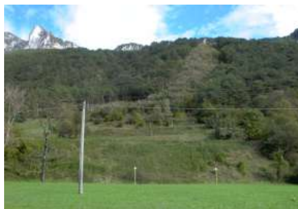
Foto 19 - Metanodotto Malborghetto – Bordano (UD) vista frontale interventi - Foto Snam Rete Gas, 2011
