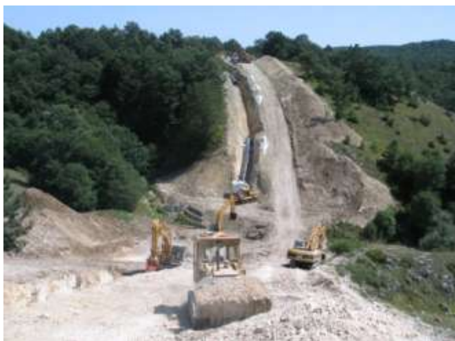
Foto 8 - Posa tubazione - 5° tronco attraversamento fosso Campolongo P.52/58 Comune di Vastogirardi – IS – Foto Snam Rete Gas
