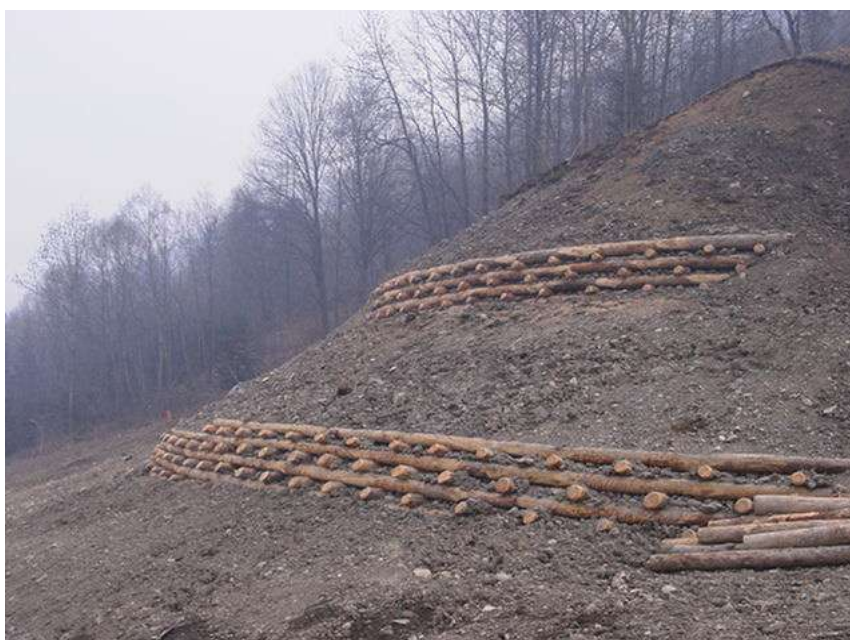
Foto 112 - Metanodotto Malborghetto – Bordano (UD) palificata viva doppia in costruzione - Foto Snam Rete Gas
