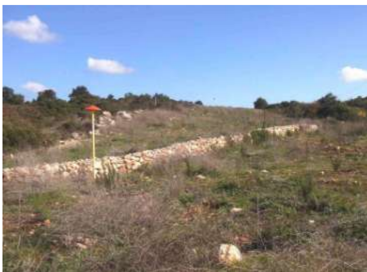
Foto 73 - Metanodotto Bernalda – Brindisi. Risultato ad un anno dai lavori di rivegetazione – Foto Snam Rete Gas
