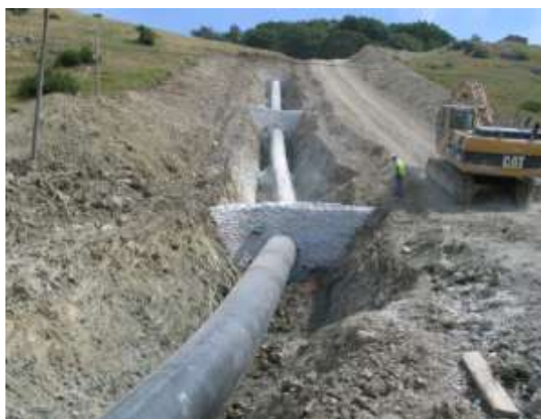
Foto 3 - Durante i lavori: realizzazione di diaframmi in sacchetti per contenimento rinterro - 5° tronco: versante P. 126/130 Loc. S.P. Montasanagrina, Vastogirardi (CB)- Foto Snam Rete Gas
