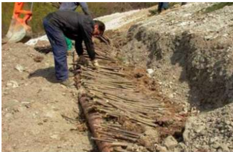
Foto 105 – Metanodotto Malborghetto – Bordano (UD) Loc. Val di Gleris; Cordonate vive per stabilizzazione di discarica di smarino di galleria – Foto Snam Rete Gas, 2005
