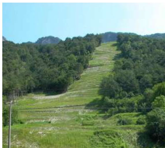
Foto 15 - Metanodotto Malborghetto – Bordano (UD) vista frontale interventi - Foto Snam Rete Gas, 2003
