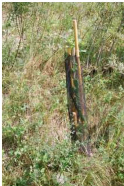
Foto 46 - Metanodotto Malborghetto – Bordano (UD) Loc. Pontebba. messa a dimora di arbusti tra le file di gradonate – Foto G. Sauli, agosto 2006
