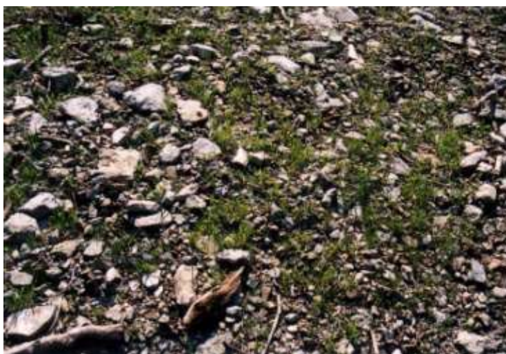
Foto 84 - Metanodotto Malborghetto – Bordano (UD) Loc. canale Cialatta. Idrosemina su suoli ricchi di scheletro – Foto G. Sauli, agosto 2003
