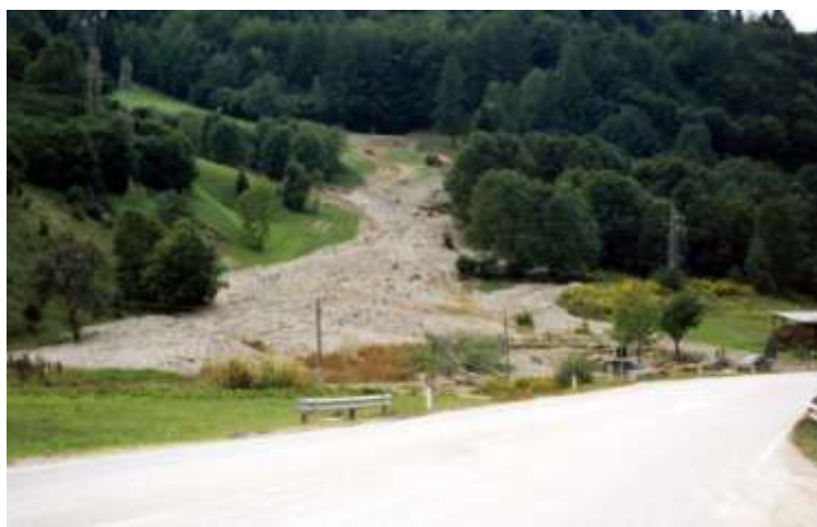
Foto 81 - Metanodotto Malborghetto – Bordano (UD) zona S. Leopoldo, effetti dell'alluvione del 29.08. '03 – Foto G. Sauli
