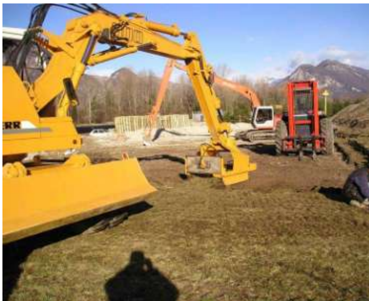
Foto 49 - Metanodotto Bordano – Flaibano (UD) loc. Piani di Osoppo, taglio ed espianto delle zolle erbose – Foto Snam Rete Gas, 2003
