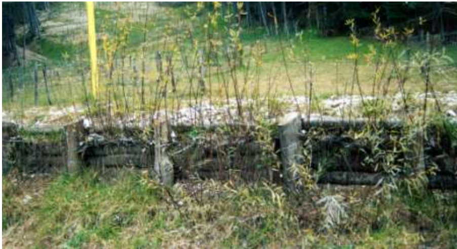
Foto 107 – Metanodotto Malborghetto – Bordano (UD) Loc. Chiaranda, palizzate vive, - Foto G. Sauli, agosto 2003
