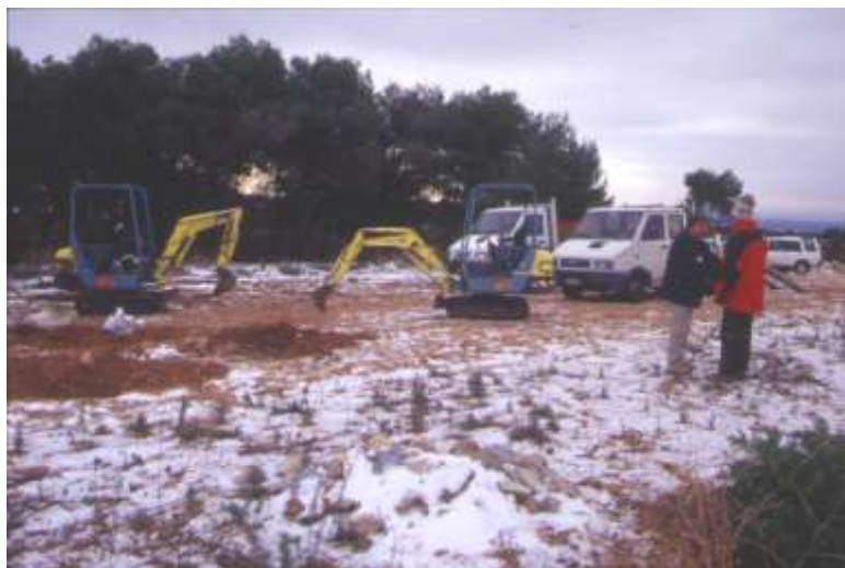
Foto 63 - Metanodotto Bernalda – Brindisi, Loc. Massafra, lavori di trapianto di arbusti di gariga mediterranea – Foto G. Sauli, dicembre 2001
