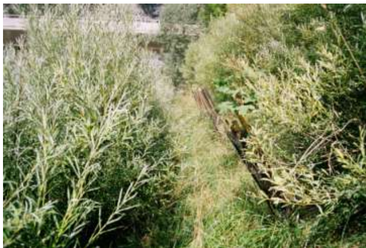
Foto 109 - Metanodotto Malborghetto – Bordano (UD) Loc. Pontebba. Particolare gradonate vive e canaletta con graticciata sviluppo dei salici ed altri arbusti dopo 3 anni – Foto G. Sauli, agosto 2006
