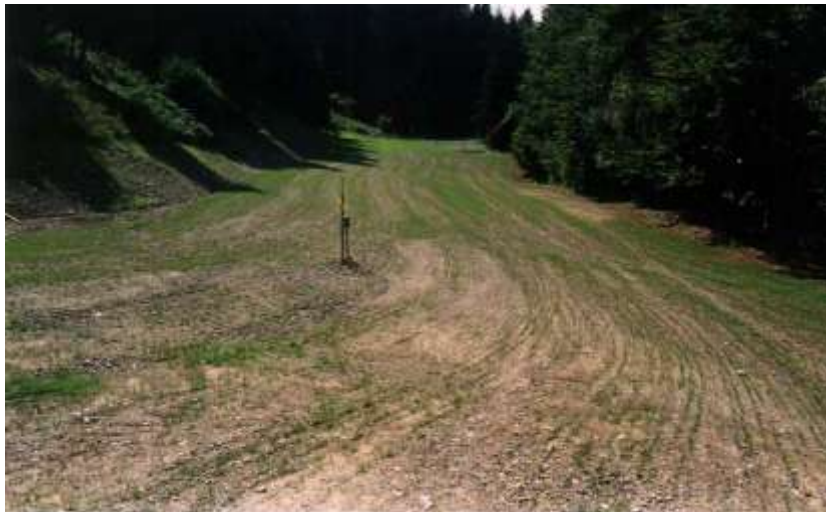
Foto 78 - Metanodotto Malborghetto – Bordano (UD) Loc. canale Cialatta. Tracciato in zona boscata, ripristino con idrosemina – Foto G. Sauli, agosto 2003
