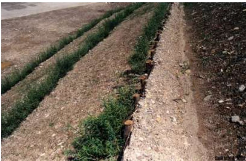
Foto 108 - Metanodotto Malborghetto – Bordano (UD) Loc. Pontebba. Particolare gradonate vive e canaletta con graticciata – Foto G. Sauli, giugno 2003
