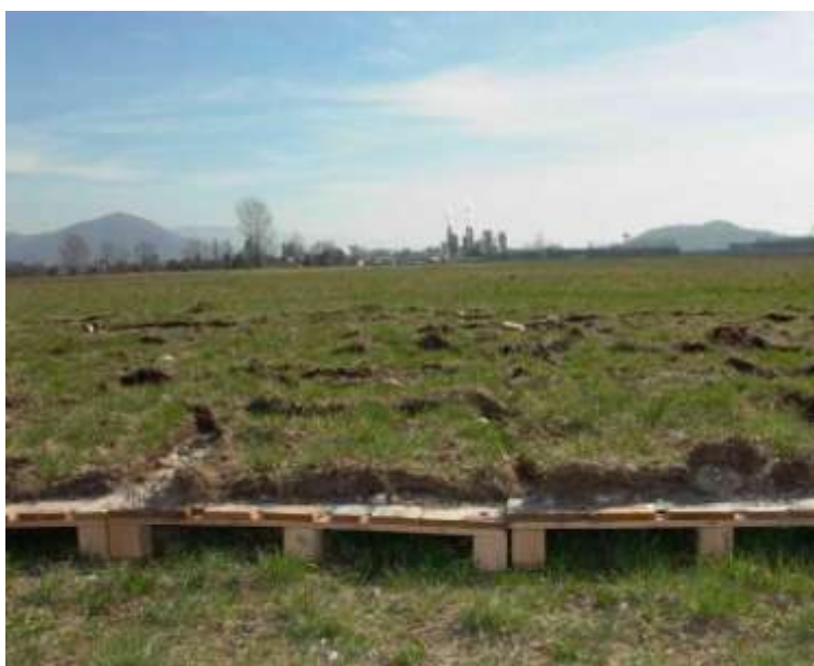
Foto 50 - Metanodotto Bordano – Flaibano (UD) loc. Piani di Osoppo, stoccaggio su pallets delle zolle – Foto Snam Rete Gas, 2003
