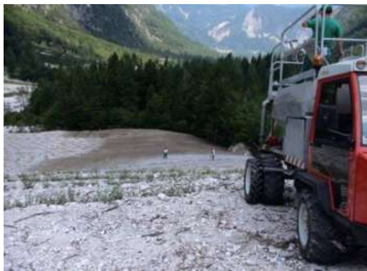
Foto 22 - Metanodotto Malborghetto - Bordano Loc. Val di Gleris. Distribuzione di fiorume e messa a dimora di arbusti autoctoni al piede della scarpata - Foto Snam Rete Gas, 2005
