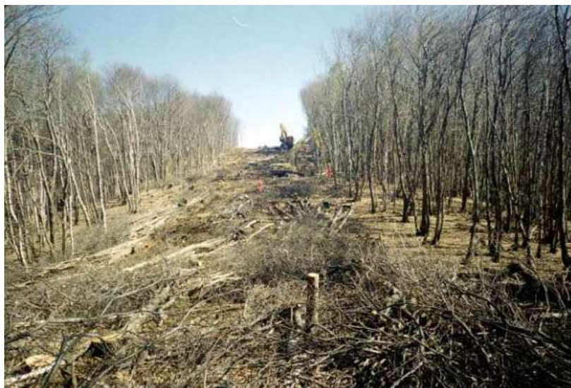
Foto 26 - Metanodotto Passo Gries – Mortara. Fase di taglio degli alberi lungo il tracciato - Foto Snam Rete Gas, 2000
