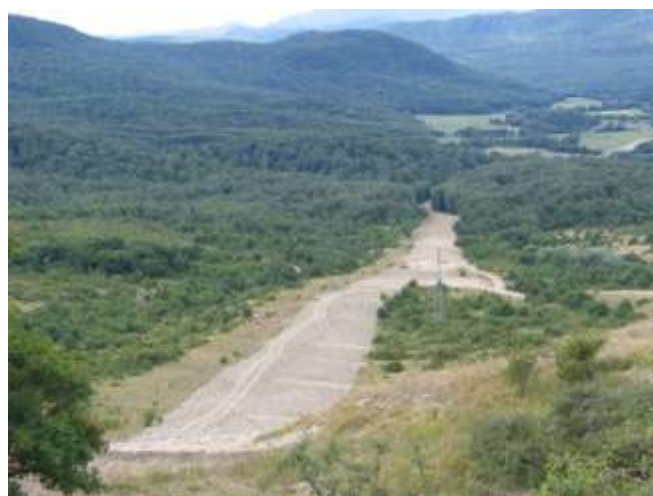
Foto 6 - Riprofilatura delle aree di lavoro (5° tronco: percorrenza area boschiva e di prebosco loc. San Nicola, Vastogirardi (CB) Veduta da P.133 verso P. 145 - Foto Snam Rete Gas
