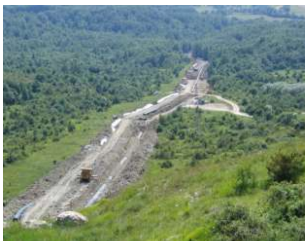
Foto 5 - Durante i lavori: scavo e montaggio della condotta - 5° tronco: percorrenza area boschiva e di prebosco loc. San Nicola, Vastogirardi (CB) Veduta da P.133 verso P. 145 - Foto Snam Rete Gas
