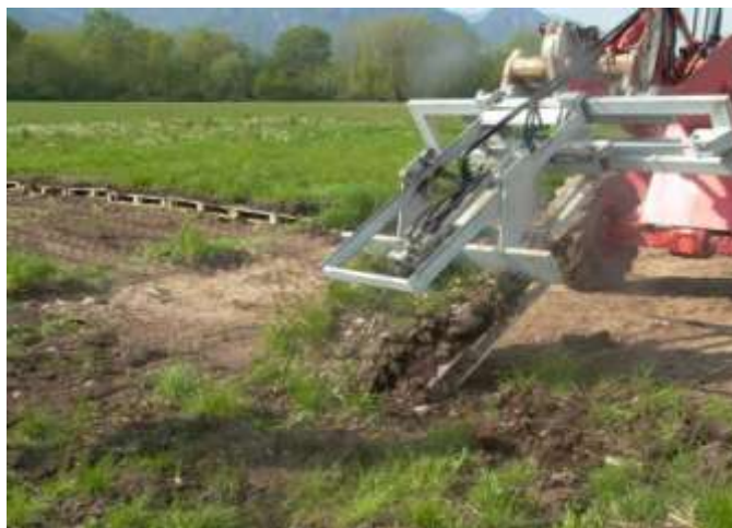
Foto 54 - Metanodotto Bordano – Flaibano (UD) loc. Piani di Osoppo, riposizionamento delle zolle – Foto Snam Rete Gas, 2004
