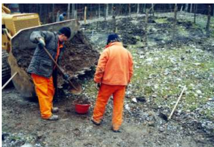
Foto 39 - Metanodotto Malborghetto – Bordano (UD) Loc. canale Cialatta. Messa a dimora di alberi e arbusti con protezione in rete metallica a “isole” rincalzo delle buche con terra vegetale locale – Foto G. Sauli, 2003
