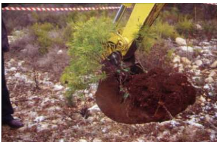
Foto 99 - Metanodotto Bernalda – Brindisi, Loc. Massafra, durante lavori di trapianto di arbusti di gariga mediterranea – Foto G. Sauli, dicembre 2001
