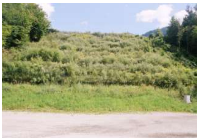
Foto 47 - Metanodotto Malborghetto – Bordano (UD) Loc. Pontebba. Gradonate vive con canaletta e messa a dimora di arbusti. Ottime risultanze funzionali e naturalistiche – Foto G. Sauli, agosto 2006
