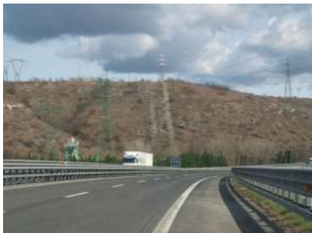
Foto 1 - M. Sei Busi Monfalcone (GO) – Visibile il tracciato dell'oleodotto transalpino soggetto a pulizia periodica (a destra) parallelo al recente metanodotto inguainato (a sinistra) non soggetto a pulizia – Foto G. Sauli, 2010
