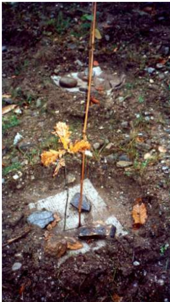
Foto 98 - Metanodotto Masera – Mortara, messa a dimora di quercia con pacciamatura in biofeltro – Foto G. Sauli, novembre 2002
