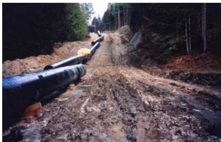
Foto 2 - Metanodotto Malborghetto – Bordano (UD) Loc. canale Cialatta. Tracciato in zona boscata con ripristino previsto a prato, fase di cantiere, Posa delle tubature – Foto G. Sauli, maggio 2002
