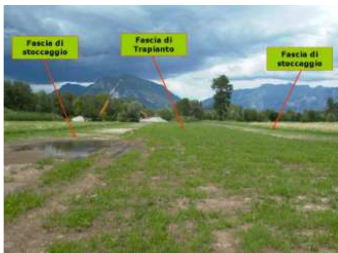
Foto 57 - Metanodotto Bordano – Flaibano (UD) loc. Piani di Osoppo, pista di lavoro ripristinata dopo 3 mesi - Foto Snam Rete Gas, luglio 2004
