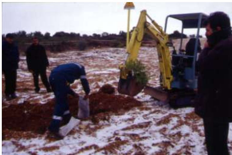
Foto 65 - Metanodotto Bernalda – Brindisi, Loc. Massafra, lavori di trapianto di arbusti di gariga mediterranea – Foto G. Sauli, dicembre 2001
