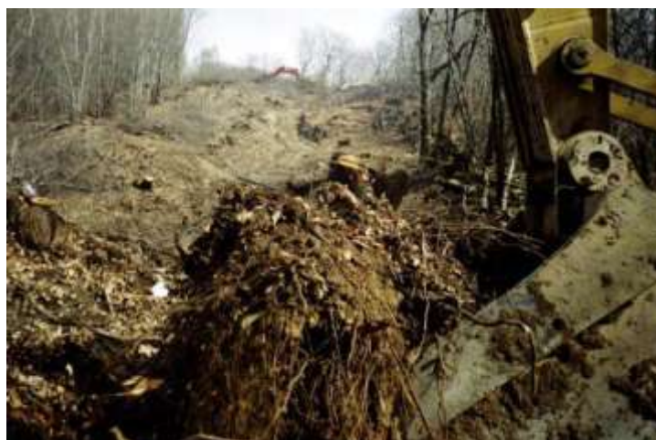
Foto 27 - Metanodotto Passo Gries – Mortara. Fase di espianto di ceppaie di castagno lungo il tracciato - Foto Snam Rete Gas, 2000
