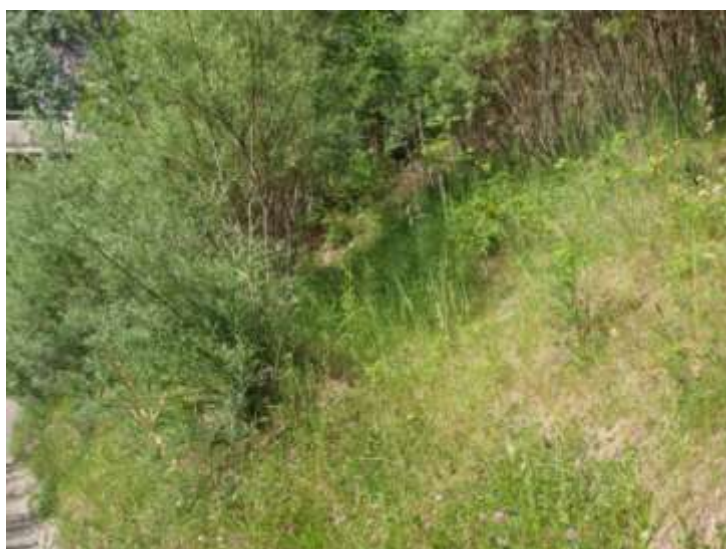
Foto 110 - Metanodotto Malborghetto – Bordano (UD) Loc. Pontebba. Particolare gradonate vive e canaletta con graticciata sviluppo dei salici ed altri arbusti dopo 7 anni – Foto G. Sauli, giugno 2010
