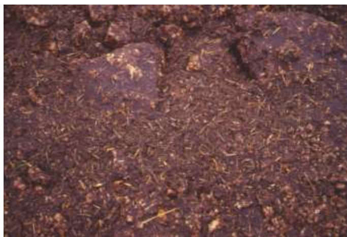
Foto 83 - Metanodotto Bernalda – Brindisi, Loc. Massafra, idrosemina con fibra organica Foto G. Sauli, dicembre 2001
