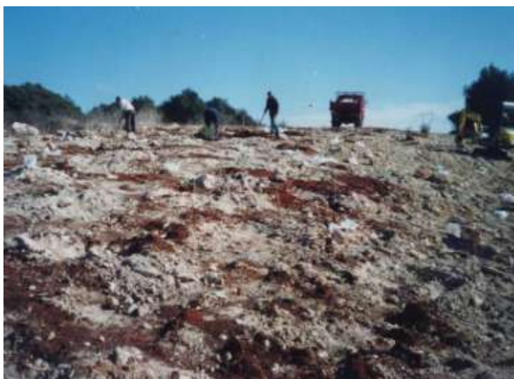
Foto 72 - Metanodotto Bernalda – Brindisi. In questo tratto è particolarmente evidente la natura dei terreni: quasi litosuoli. Questa è una caratteristica anche dei tratti indisturbati, seppur più strutturati e uniformemente “colonizzati” dalle cenosi erbacee e arbustive – Foto Snam Rete Gas
