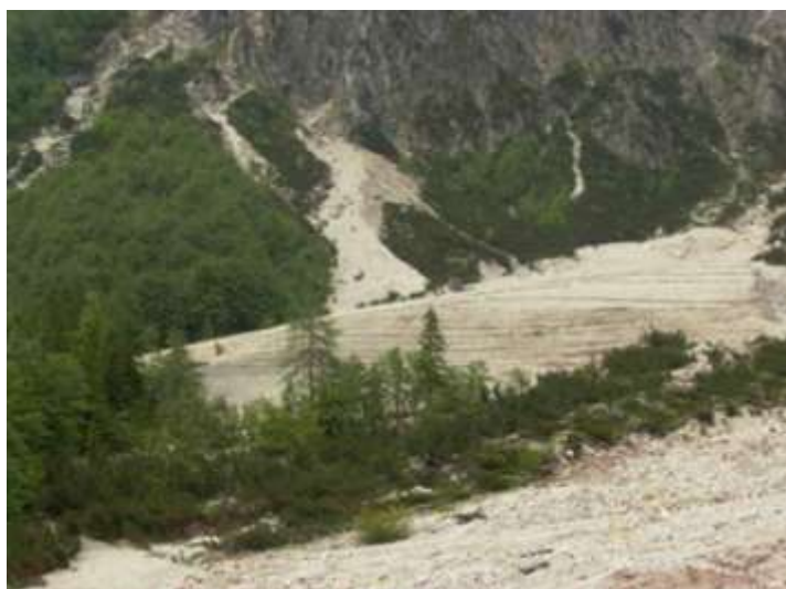
Foto 20 - Metanodotto Malborghetto - Bordano Loc. Val di Gleris. Interventi con cordonate vive sulle scarpate del deposito - Foto Snam Rete Gas, 2005
