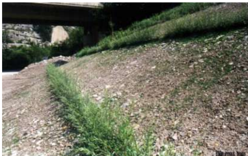
Foto 45 - Metanodotto Malborghetto – Bordano (UD) Loc. Pontebba. Gradonate vive – Foto G. Sauli, giugno 2003
