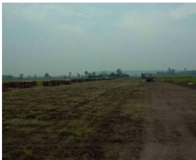
Foto 55 - Metanodotto Bordano – Flaibano (UD) loc. Piani di Osoppo, pista di lavoro ripristinata – Foto Snam Rete Gas, 2004
