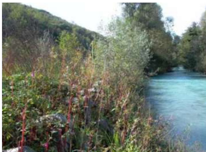
Foto 116 - Metanodotto Bordano – Flaibano, Fiume Ledra dopo 4 anni –Foto Snam Rete Gas, 2009
