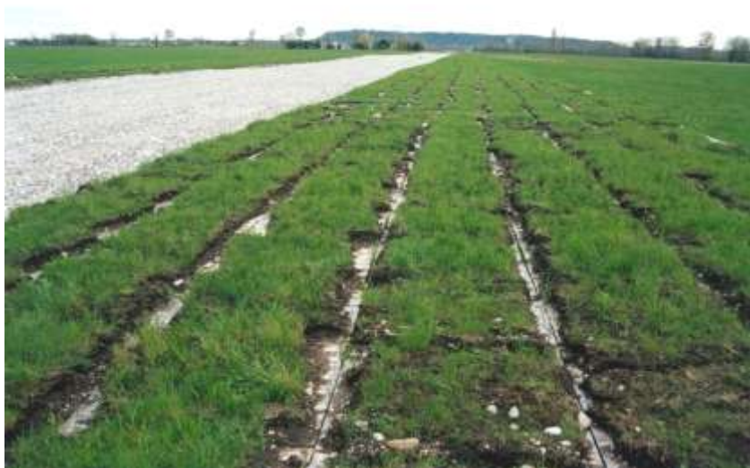
Foto 88 - Metanodotto Bordano – Flaibano (UD). Zolle erbose pronte per il trapianto – Foto G. Sauli, 2003
