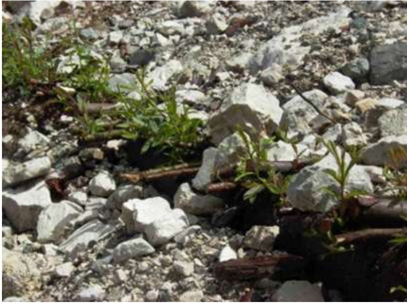
Foto 106 - Metanodotto Malborghetto – Bordano (UD) Loc. Val di Gleris. Cordonate vive ricaccio dei salici – Foto Snam Rete Gas, 2005
