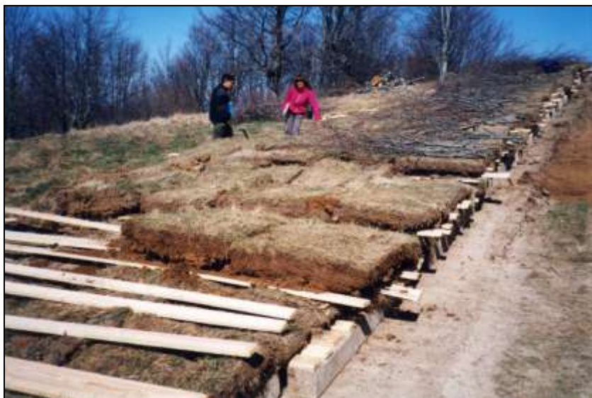
Foto 89 - Fase di stoccaggio zolle erbose a bordo pista. Prateria in quota (1200 m). Loc. Monte Polo, Corniglio (PR) - Foto Snam Rete Gas, 2003
