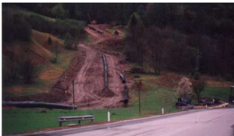
Foto 79 - Metanodotto Malborghetto – Bordano (UD) zona S. Leopoldo, fase di cantiere – Foto G. Sauli, gennaio 2002
