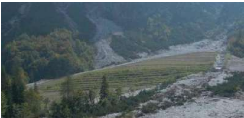
Foto 25 - Metanodotto Malborghetto - Bordano Loc. Val di Gleris. Interventi con cordonate vive sulle scarpate del deposito dopo quattro anni - Foto Snam Rete Gas, 2009
