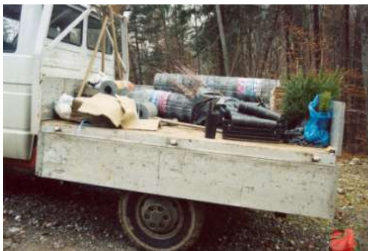
Foto 38 - Metanodotto Malborghetto – Bordano (UD) Loc. canale Cialatta. Messa a dimora di alberi e arbusti con protezione in rete metallica a “isole” – Foto G. Sauli, 2003
