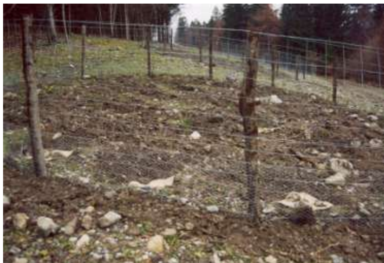
Foto 41 - Metanodotto Malborghetto – Bordano (UD) Loc. canale Cialatta. Protezione a “isole”, particolare rete a maglia fitta antilepre – Foto G. Sauli, 2003
