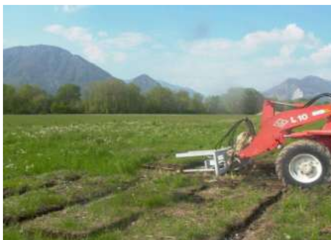
Foto 52 - Metanodotto Bordano – Flaibano (UD) loc. Piani di Osoppo, prelievo delle zolle – Foto Snam Rete Gas, aprile 2004
