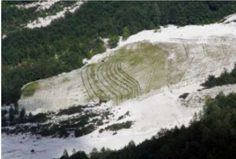
Foto 23 - Metanodotto Malborghetto - Bordano Loc. Val di Gleris; panoramica degli interventi di IN sulla deponia derivata dallo scavo galleria metanodotto – Foto V. Zago, luglio 2007
