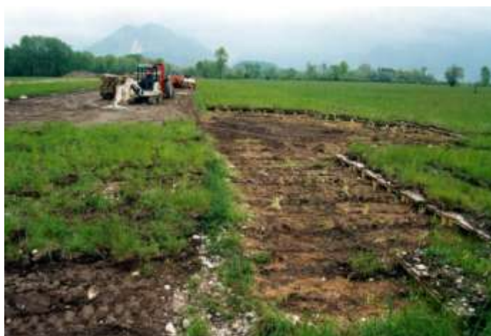
Foto 53 - Metanodotto Bordano – Flaibano Loc. Piani di Osoppo; trapianti in zolla, rimessa in pristino delle zolle – Foto G. Sauli, 2004
