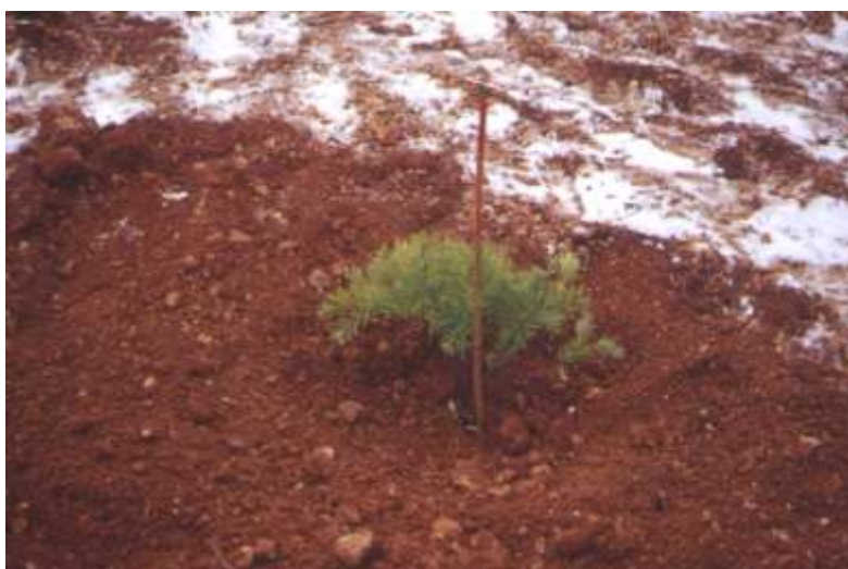
Foto 67 - Metanodotto Bernalda – Brindisi, Loc. Massafra, lavori di trapianto di arbusti di gariga mediterranea – Foto G. Sauli, dicembre 2001
