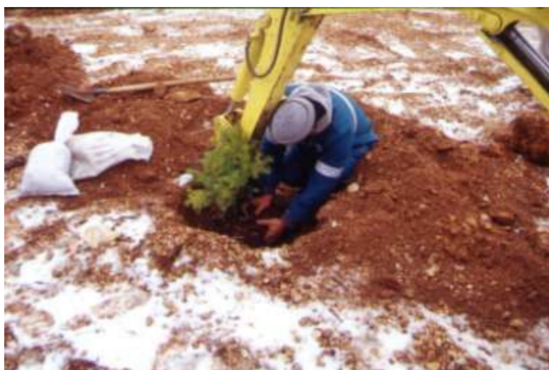
Foto 66 - Metanodotto Bernalda – Brindisi, Loc. Massafra, lavori di trapianto di arbusti di gariga mediterranea – Foto G. Sauli, dicembre 2001
