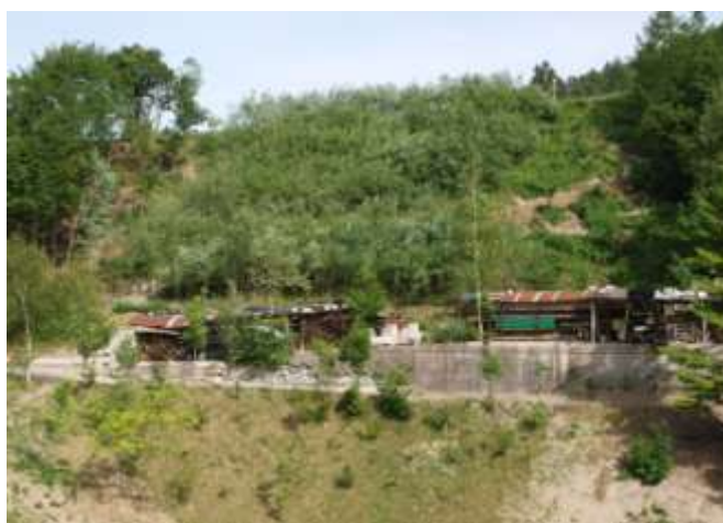
Foto 48 - Metanodotto Malborghetto – Bordano (UD) Loc. Pontebba. Gradonate vive con canaletta e messa a dimora di arbusti. Ottime risultanze funzionali e naturalistiche dopo 7 anni anche in termini di biodiversità con costituzione di cespuglieti in zona boscata – Foto G. Sauli, giugno 2010
