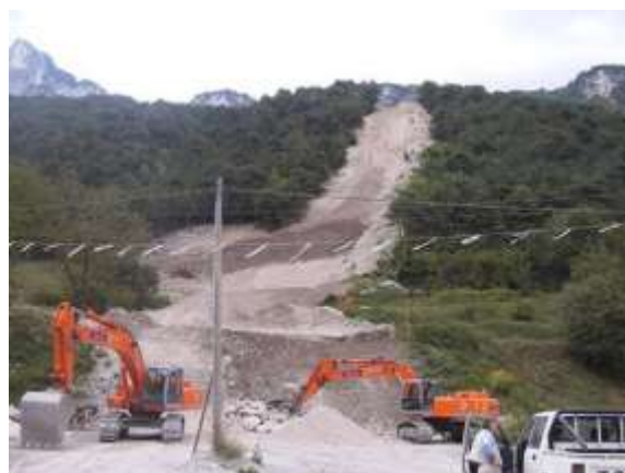
Foto 13 – Metanodotto Malborghetto – Bordano (UD) vista frontale interventi - Foto Snam Rete Gas, 2002
