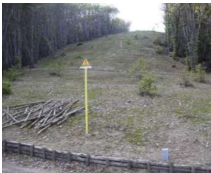
Foto 32 - Metanodotto Passo Gries – Mortara. Particolari delle ceppaie dopo la riprofilatura della pista di lavoro. Nella porzione centrale le ceppaie espianate e in quella laterale quelle salvaguardate in pista durante i lavori - Foto Snam Rete Gas, 2003
