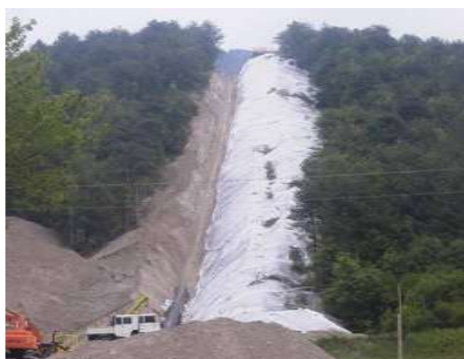
Foto 12 – Metanodotto Malborghetto – Bordano (UD) vista frontale interventi - Foto Snam Rete Gas, 2002
