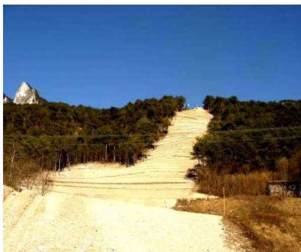
Foto 14 - Metanodotto Malborghetto – Bordano (UD) vista frontale interventi - Foto Snam Rete Gas, 2002
