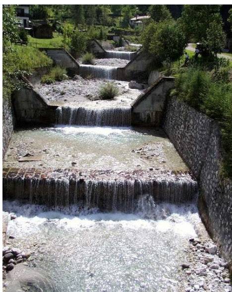
Figura 4.25 – Alveo a fondo artificiale sistemato con briglie ad interdistanza ridotta (T. Pramper, Belluno).
