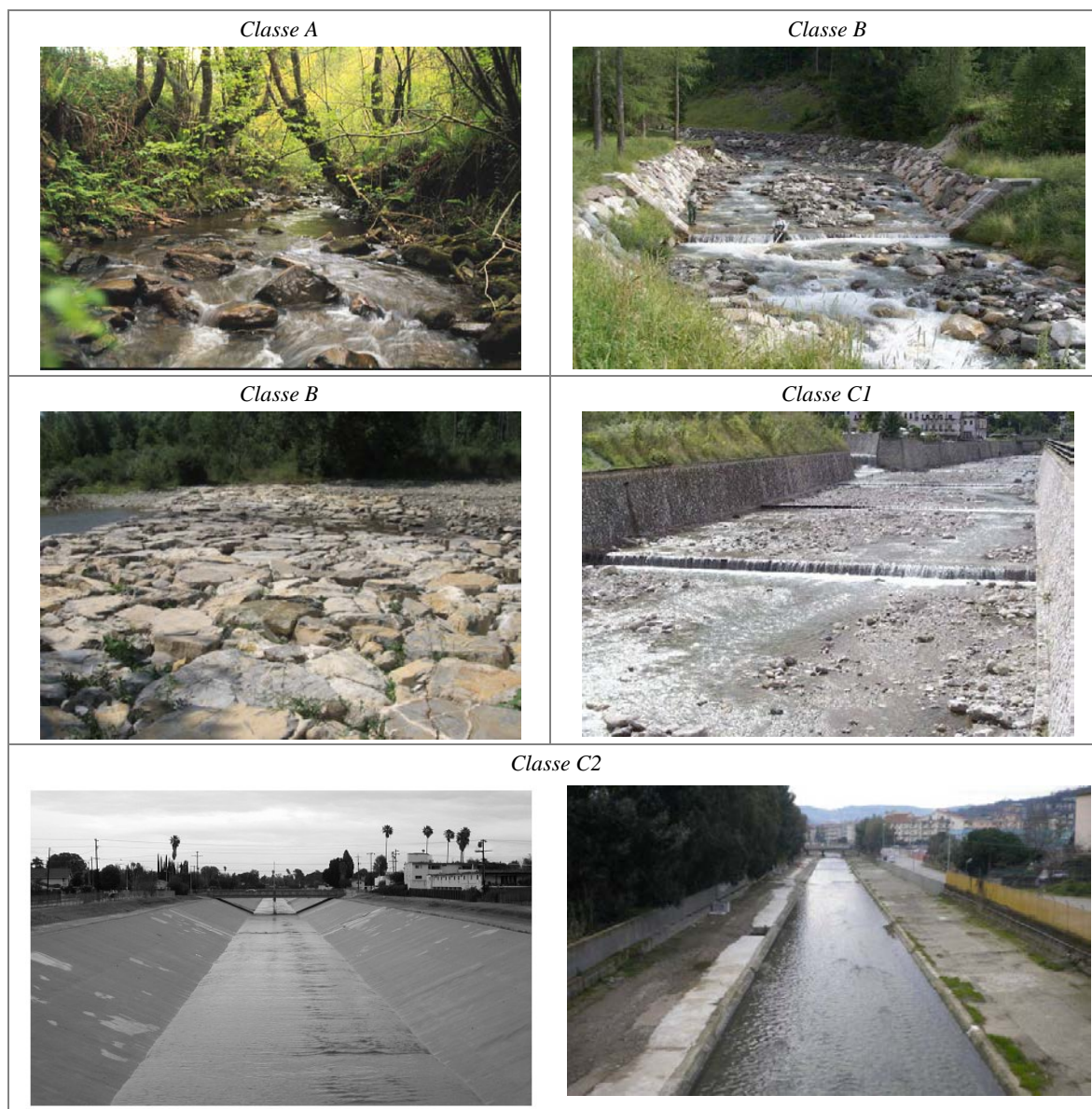
Figura A4.73 – Altre opere di consolidamento e rivestimenti. Classe A : alveo con totale assenza di opere di consolidamento o rivestimento del fondo. Classe B : presenza di soglie (prima riga a destra) o di rampe in massi (seconda riga a sinistra) con bassa densità. Classe C1 : presenza di numerose soglie e parziale rivestimento del fondo. Classe C2 : totale rivestimento del fondo con tipologia impermeabile. Nel caso tale rivestimento interessa gran parte del tratto (> 80%), si assegna una penalità aggiuntiva di 12 .
