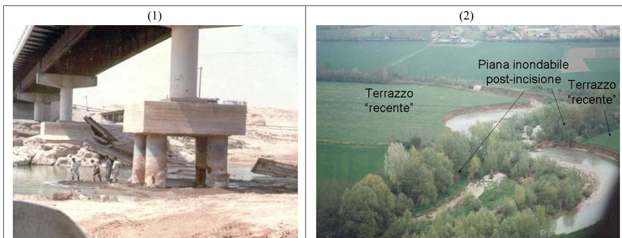
Figura A4.81 – Evidenze sul terreno di incisione. (1) Erosione alle pile dei ponti; (2) dislivelli tra piana inondabile post- incisione e terrazzo recente (corrispondente alla piana inondabile pre-incisione).
