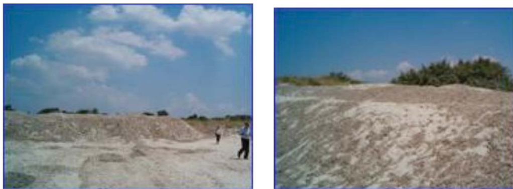
Figura 2.3.16 - Particolari dell'utilizzo della banquette per la ricostituzione del fronte dunale (Foto: N. Ungaro).
