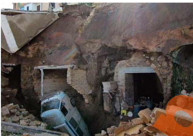
Fig.16 - Anno 2011, crolli di cantine scavate all'interno della rupe tufacea. - Year 2011, collapses of cellars dug inside the tufa cliff.
