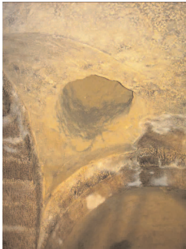
Fig. 18 – Distacchi di detriti dalla volta della cavità. – Debris detachment from cavity vault.
