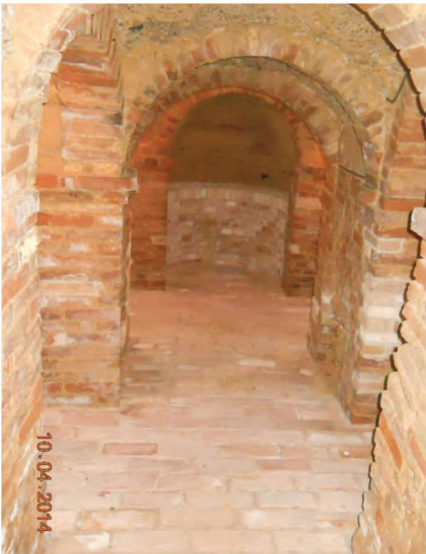
Fig. 6 – Cavità con rivestimento in muratura. – Cavity with coating masonry.
