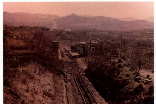
Fig. 100. – Territorio comunale di S. Lucido in provincia di Cosenza, linea ferroviaria Paola-Cosenza. I binari sono deformati e la Stazione S. Lucido-Falconara Albanese risulta inclinata per riattivazione di una grande frana (3 x 5 km) i cui segnali più antichi di attività risalgono al terremoto del 1783 (fotografia di L. Merenda, CNR-IRPI Cosenza).
