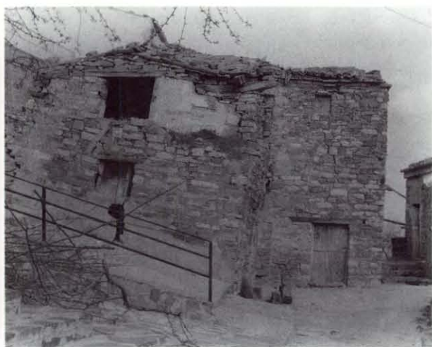
Fig. 107. – Territorio comunale di Castroregio in provincia di Cosenza. Residui di fabbricati interessati da movimenti franosi (fotografia dell'autore, 22 aprile 1987).
