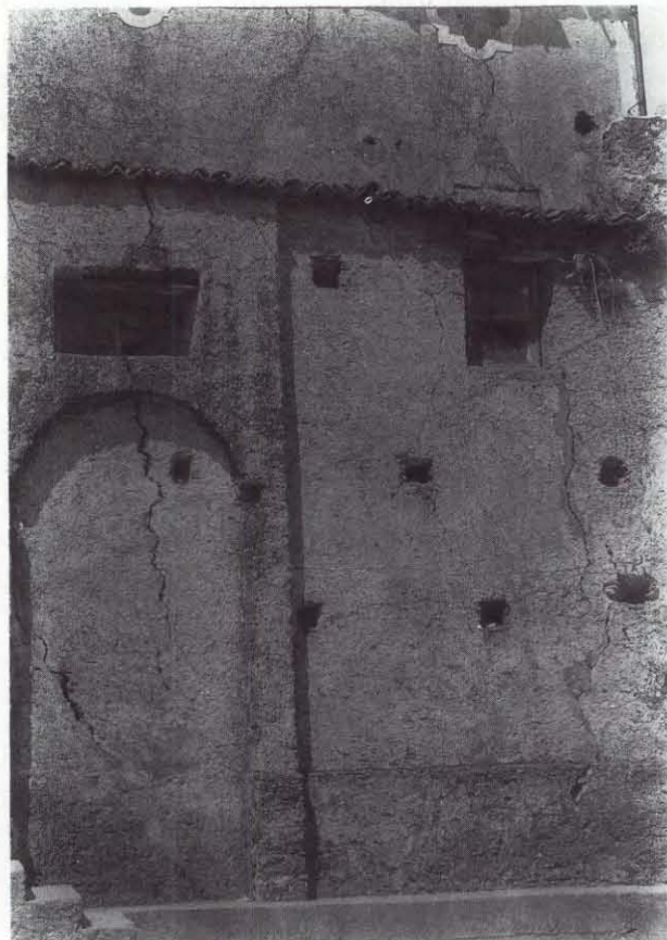
Fig. 109. – Territorio comunale di Bonifati in provincia di Cosenza. La Chiesa Madre con evidenti lesioni provocate da dissesti pregressi; l'area orientale dell'abitato, su cui essa insiste, è tuttora interessata da scorrimenti attivi (fotografia dell'autore, 23 aprile 1987).
