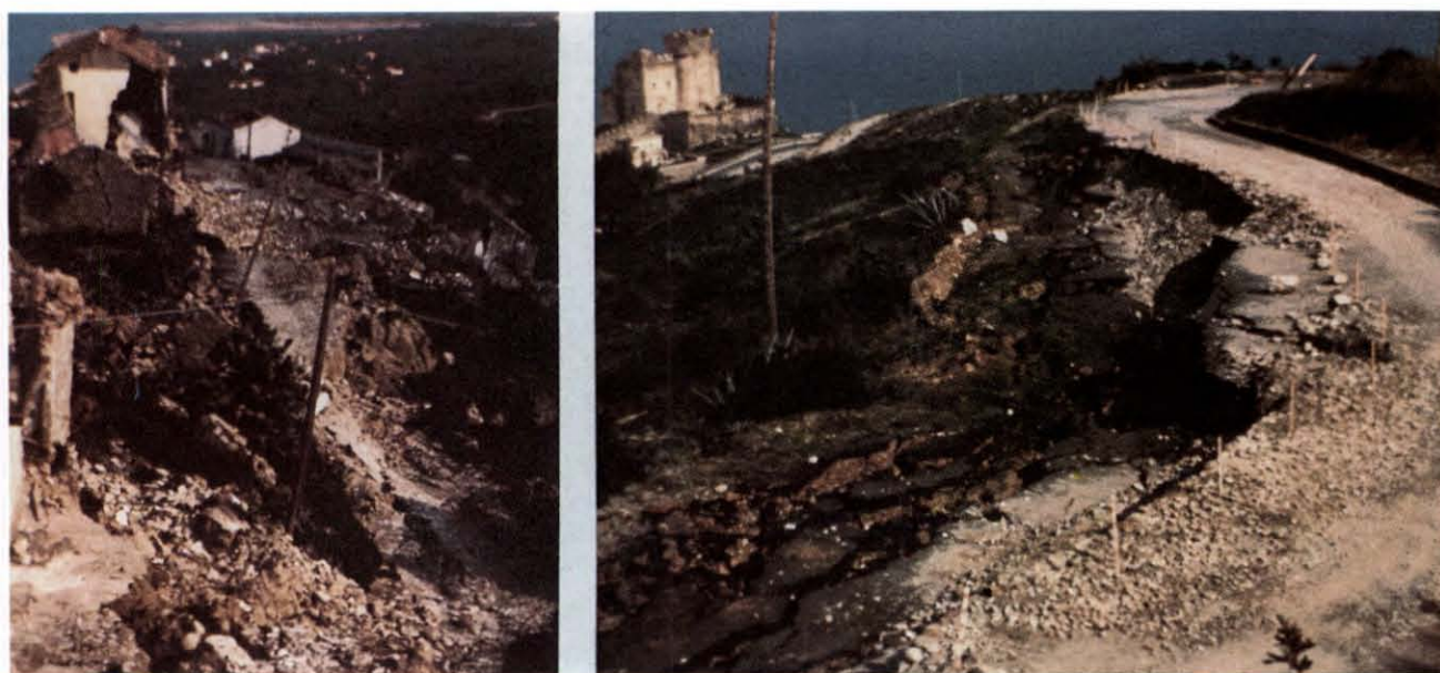
Fig. 108. – Territorio comunale di Roseto Capo Spulico in provincia di Cosenza. La zona, come visibile nelle due immagini, è quasi ovunque dissestata da movimenti franosi. L'abitato fu inserito nel 1958 nella lista dei comuni da consolidare, e nei quindici anni successivi fu oggetto di numerosi provvedimenti con stanziamento di fondi che non saranno mai spesi (fotografie di L. Merenda, CNR-IRPI Cosenza).
