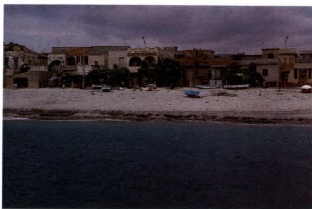
Fig. 110. – Frana subacqua di Catona in provincia di Reggio Calabria, 17 giugno 1987. Lo scalino lungo la battigia corrisponde alla nicchia di distacco ( fotografia dell'autore ).
