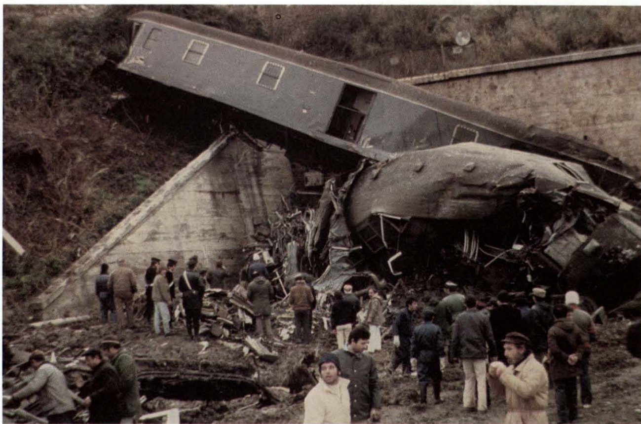
Fig. 104. – Territorio comunale di Bonifati (località Cittadella) in provincia di Cosenza, 21 gennaio 1981. Disastro ferroviario sulla linea Salerno-Reggio Calabria. L'espresso 689 diretto a Reggio incontra, all'imbocco di una galleria, materiali di frana che ostruiscono i binari. Il locomotore si spezza in due tronconi e gli altri quattro vagoni si accatastano l'uno su l'altro. Sfiiorata una tragedia più grave in quanto l'espresso Reggio-Roma, in transito in senso opposto, urta lievemente solo una delle carrozze deragliate. Il bilancio è di 4 morti e 19 feriti (fotografia di L. Merenda, CNR-IRPI Cosenza).
