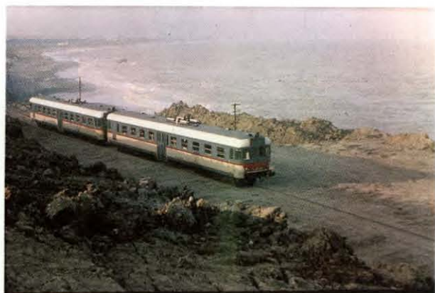
Fig. 101. - Tratto della ferrovia Sibari-Taranto in provincia di Cosenza (Alto Ionio) appena liberato dai materiali di una frana per colamento che ha pure coinvolto la SS. n. 106, marzo-aprile 1973 (fotografia di L. Merenda, CNR-IRPI Cosenza).
