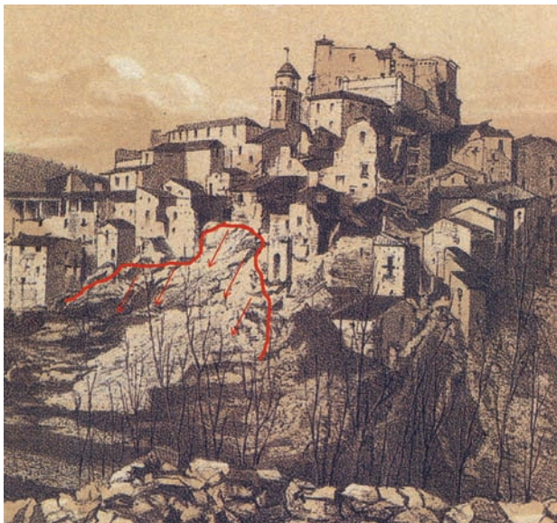
Fig. 4 - Rappresentazione del versante meridionale dell'abitato di Brienza in Basilicata in cui sono evidenti fenomeni di colamento innescatisi per effetto del terremoto del 1857 (mod. da MALLETT, 1862). - View of the southern slope of Brienza town in Basilicata in which earthflow and mudflows phenomena, triggered by the 1857 earthquake, are shown (from MALLETT, 1862, and modified).
