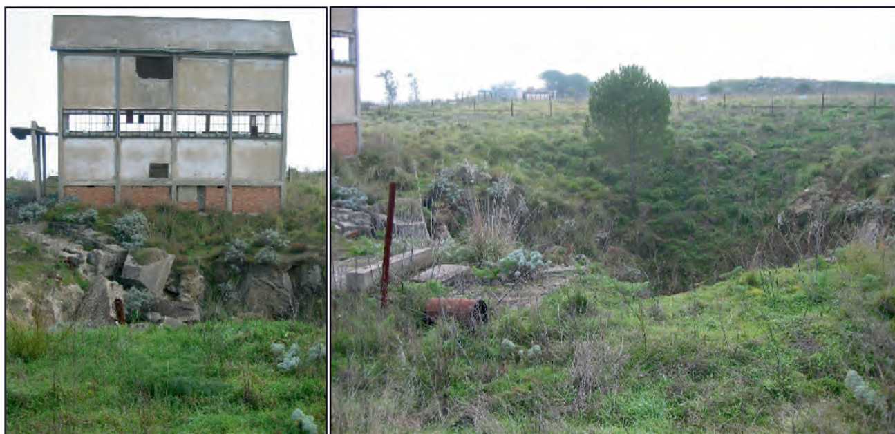
Fig. 5 - Immagine fotografica del sinkhole. - Sinkhole photo in Montedoro area.
