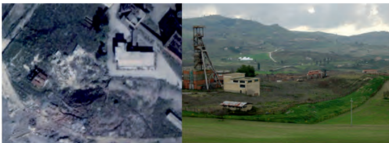
Fig. 6 - Sinkhole della miniera Racalmuto. La zona interessata dal sinkhole è stata messa in sicurezza attraverso due recinzioni con l'obiettivo di impedire l'accesso.
