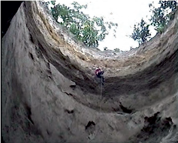
Fig. 13 – Sinkhole provocato dal crollo della volta di una cava in tufo in via Scaglione 8 (foto: Comune di Napoli). – Sinkhole due to the collapse of underground cavity in Scaglione Street (photo: Naples Municipality).
