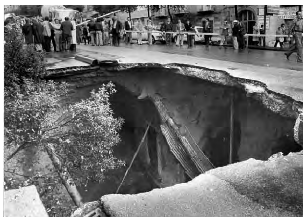
Fig. 15 – Settembre 1979: sinkhole in corso Amedeo di Savoia (fonte: http://www.nisalfe.it/PAGINE/pagina_NAPOLI/sottosuolonapoli.pdf ). – September 1979: sinkhole occurred in Amedeo di Savoia Street (from: http://www.nisalfe.it/PAGINE/pagina_NAPOLI/sottosuolonapoli.pdf ).
