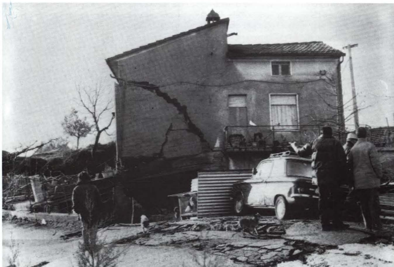
Fig. 54. - Dissesti in un edificio privato per movimento franoso probabilmente attivato da scosse sismiche. Monteverde di Valfabbrica in provincia di Perugia, 22 dicembre 1982 (gentile concessione ANSA).
