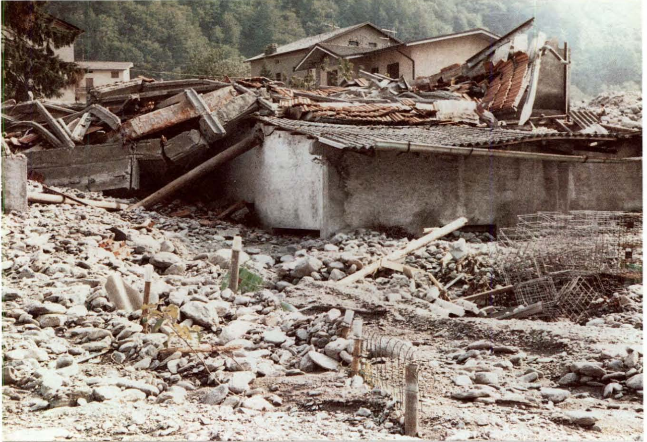
Fig. 19. – Valtellina, provincia di Sondrio, territorio comunale di Fusine. Effetti del trasporto in massa torrentizio. I fabbricati sono sepolti da materiale detritico fino ai primi piani, talora fin quasi al tetto. Alluvioni del 17-19 luglio 1987 (fotografia dell'autore).
