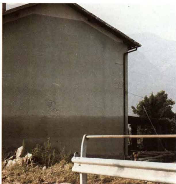
Fig. 22. - Valtellina, provincia di Sondrio, alluvioni del 17-19 luglio 1987. La fascia scura alla base del fabbricato indica l'altezza raggiunta dalle acque d'inondazione del F. Adda in sponda destra, zona Campovico-Ardenno (fotografia dell'autore).
