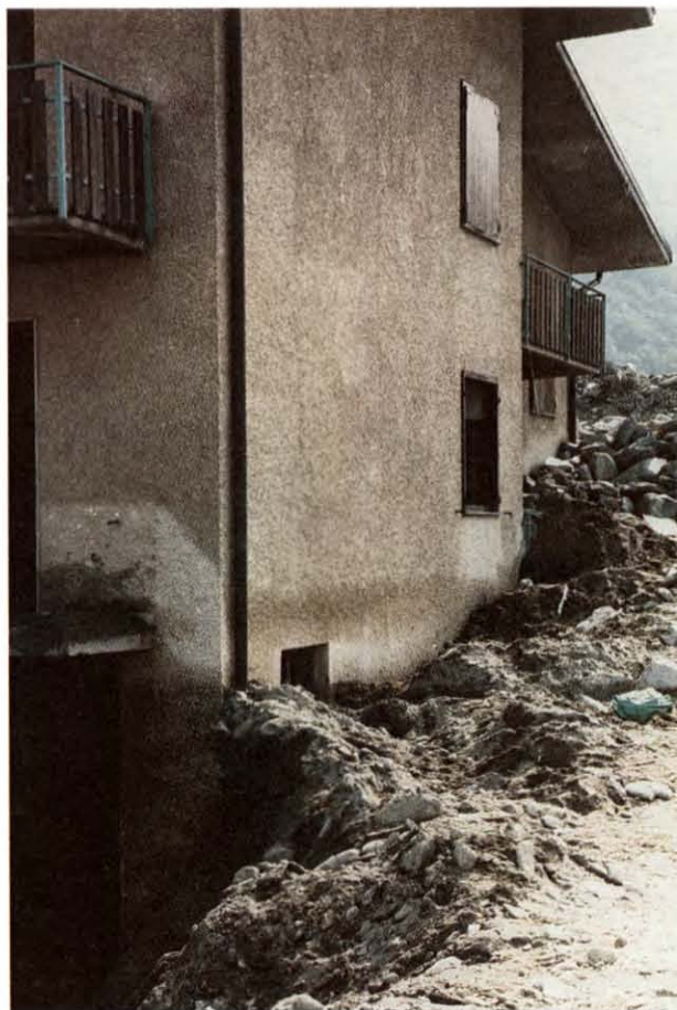
Fig. 20. - Valtellina, provincia di Sondrio, alluvioni del 17-19 luglio 1987. Centro abitato di Fusine invaso da depositi alluvionali (trasporto in massa torrentizio) con altezze che raggiungono i primi piani delle abitazioni (fotografia dell'autore).
