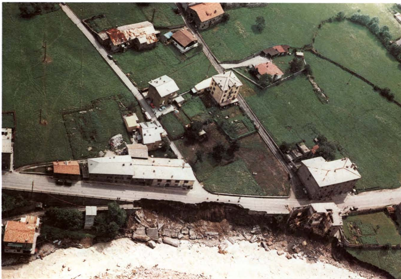
Fig. 18. – Valtellina, provincia di Sondrio. F. Adda, erosione di sponda con danneggiamento di abitazioni e della SS. n. 38, 17-19 luglio 1987 (fotografia dell'autore).
