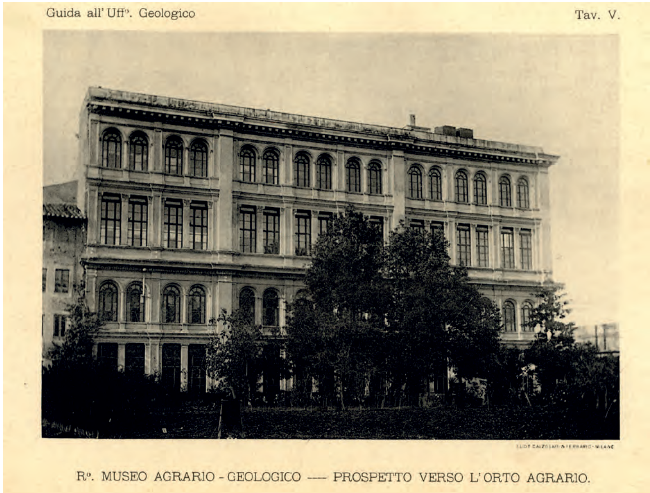
Fig. 2 – Prospetto dell'edificio del Museo Geologico Agrario (1904). – Prospect of the Agricultural and Geological Museum building (1904).
