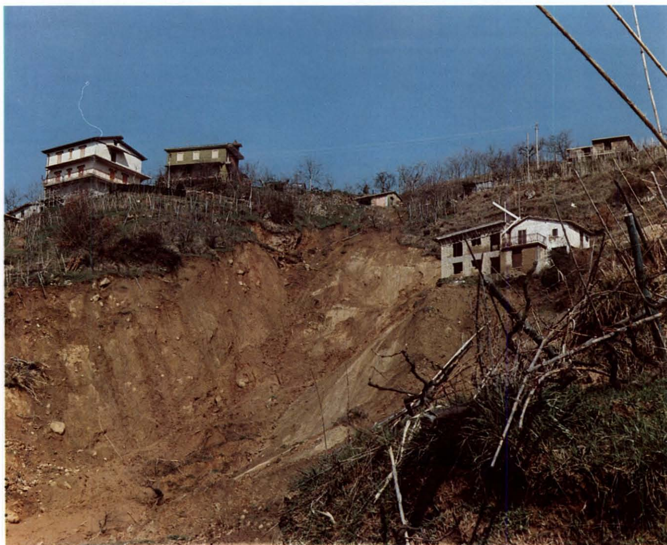
Fig. 56. – Località Colanicchio in territorio comunale di Bellegra, provincia di Roma. Franamento con danni ad edifici privati, alcuni di recente costruzione, 19 febbraio 1986 ( fotografia di M. Sciotti, Facoltà di Ingegneria, Università di Roma ).
