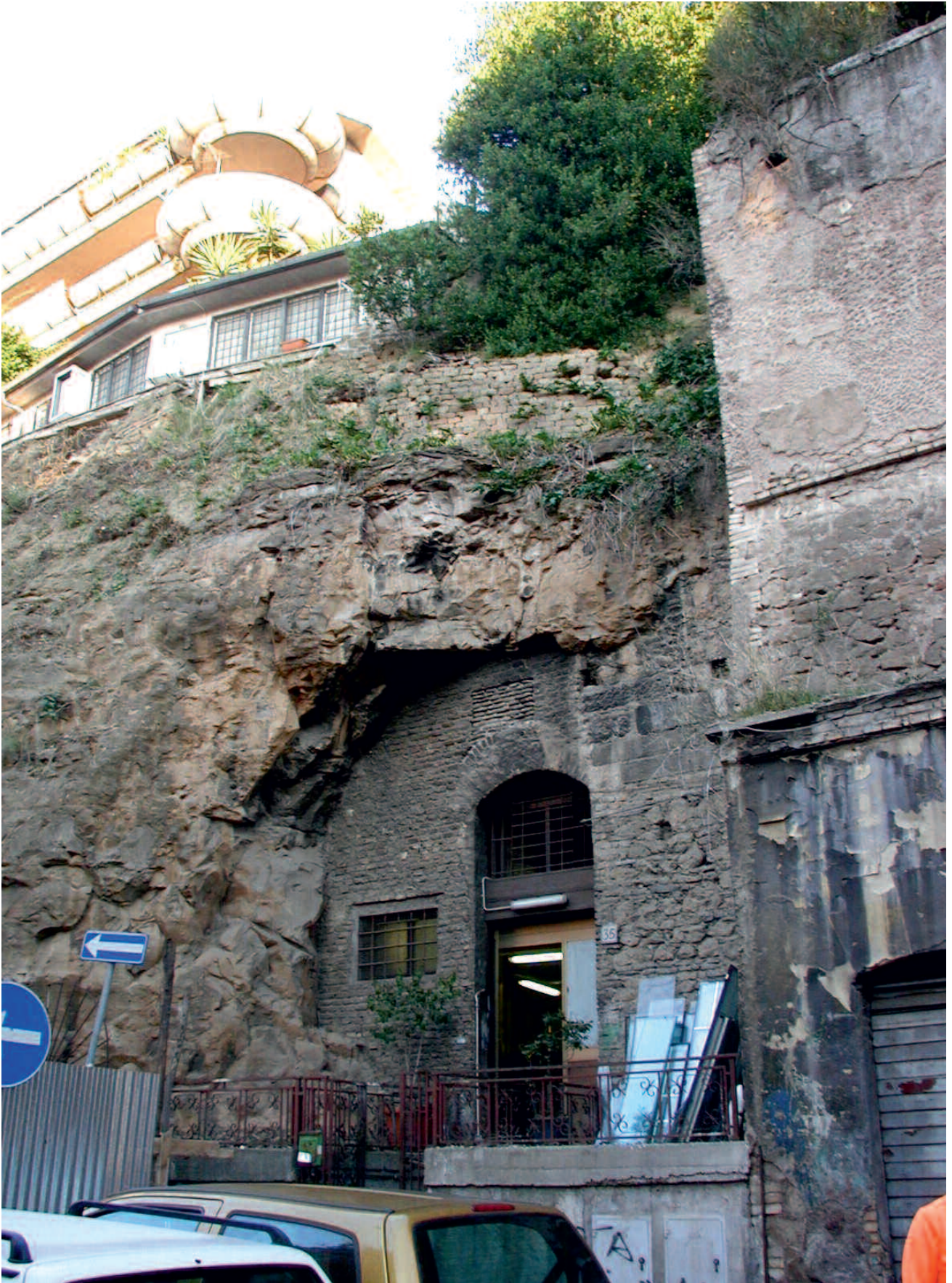
Fig. 17 – Accessi alla rete caveale di Via G. Parrasio. - Access to cave of Via G. Parrasio.
