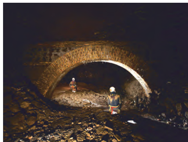
Fig. 9 – Struttura muraria di sostegno. - Structure of wall support.
