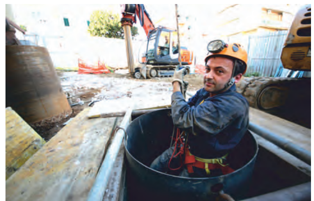
Fig. 1 – Accesso alla rete caveale da pozzo incamiciato con tecnica di progressione su fune.
