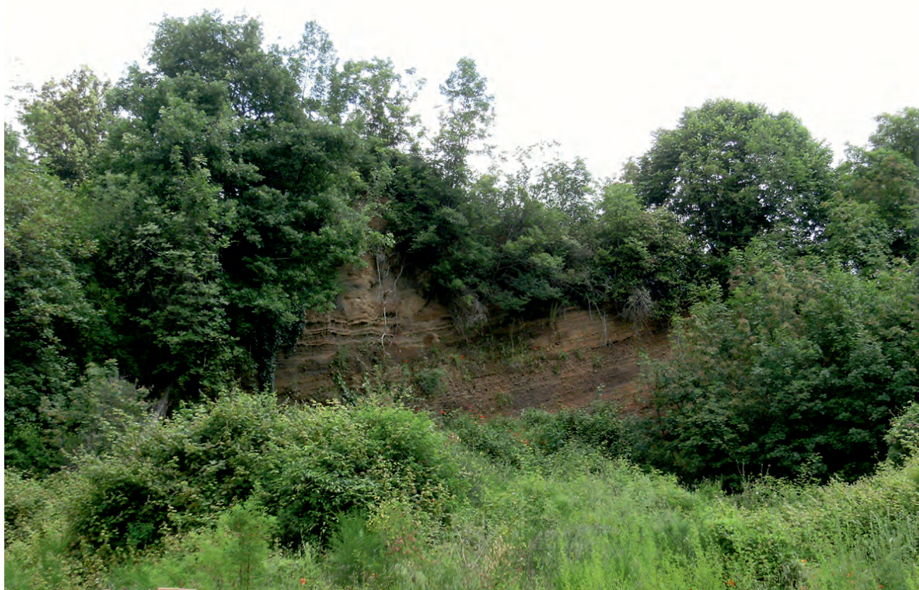
Fig. 5 - Visione del fronte di cava. Si intravedono le geometrie di messa in posto del deposito vulcanico e la differenziazione tra prodotti grossolani e prodotti a granulometria minore.
