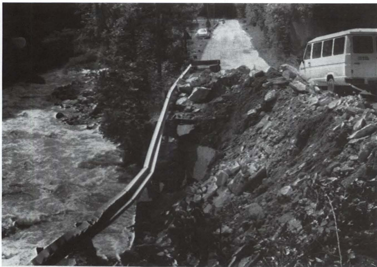
Fig. 31. – Valle Sarentina in provincia di Bolzano. Effetti dell'erosione di sponda provocata dalle acque di T. Talvera, 16 maggio 1985 (gentile concessione ANSA).
