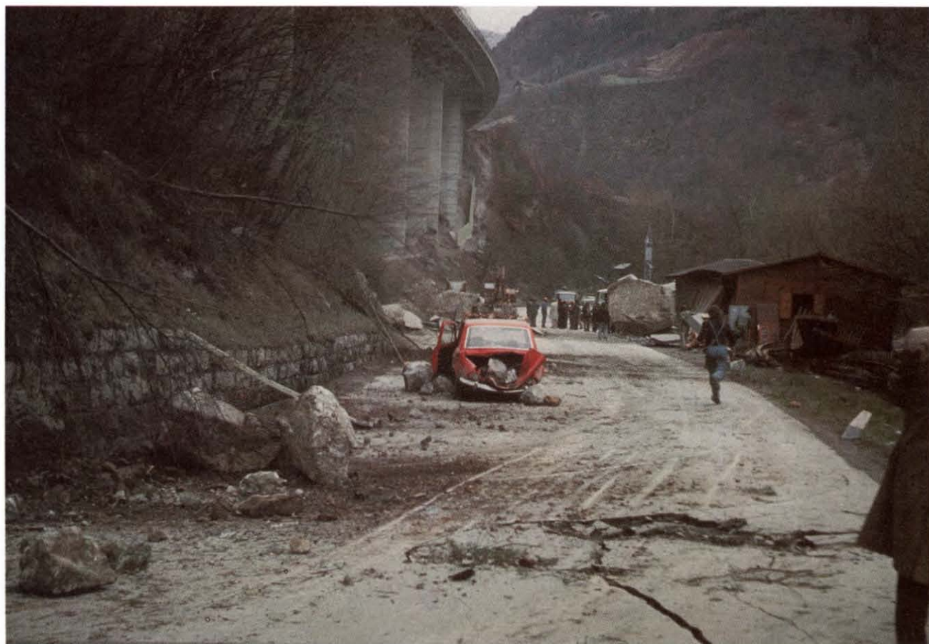
Fig. 29. – Territorio comunale di Renon in provincia di Bolzano, presso Campodazzo. Danneggiamenti provocati da un franamento per crollo e rotolamento lungo la strada del Brennero, 13 aprile 1975 ( fotografia di V. Spagna, Regione Veneto ).
