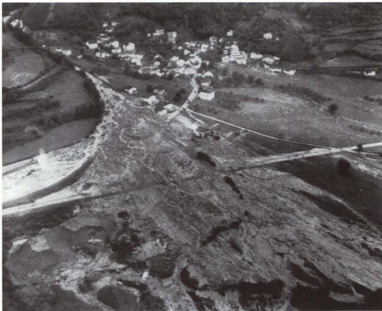
Fig. 30. – Montechiaro in territorio comunale di Prato allo Stelvio in Val Venosta, presso la confluenza con la Valle di Trafoi, provincia di Bolzano. Danni ad abitazioni e alla sede stradale provocati dal trasporto di massa torrentizio innescatosi lungo il Rio Cavallaccio, 22-23 maggio 1983 (gentile concessione ANSA).
