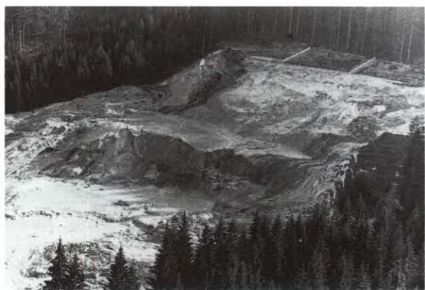
Fig. 34. – Frana della Val di Stava, comune di Tesero in provincia di Trento, 19 luglio 1985. Veduta dei resti del bacino superiore (fotografia Corriere della Sera, luglio 1985).
