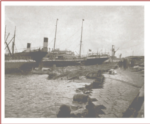
Fig. 22 - Effetti del maremoto e del terremoto sulla banchina del porto di Messina (Foto Avv. LUIGI LODI-FOCARDI, 1909). - Effects of the seaquake and the earthquake on the Messina harbor bench (Photo Avv. LUIGI LODI-FOCARDI 1909).
