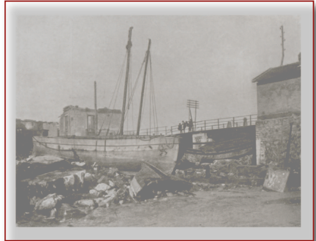
Fig. 30 - Effetti del maremoto a Villa San Giovanni, dove le barche sono state trascinate dalle onde a circa 80 m dal mare (Foto Avv. LUIGI LODI-FOCARDI, 1909). - Effects of the seaquake in Villa St. Giovanni, where the boats have been dragged by the waves at about 80 ms from the sea (Photo Avv. LUIGI LODI-FOCARDI, 1909).
