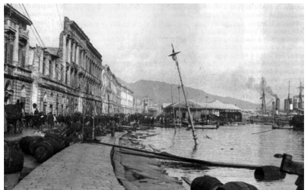
Fig. 12 - La banchina del porto devastata dalle onde di maremoto e la Palazzata gravemente danneggiata (Fonte: Collezione privata). - The quay devastated by the seaquake waves and the Palazzata badly damaged. (Private collection).
