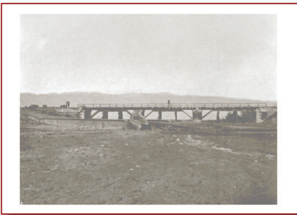
Fig. 29 - Effetti del maremoto a Pellaro, dove si vedono i resti di un ponte ferroviario asportato dalle onde ed una barca portata in questo punto dal mare (Foto Avv. LUIGI LODI-FOCARDI, 1909). - Effects of the seaquake to Pellaro, where are the remains of a railway bridge removed by the waves and a boat brought in this point by the sea (Photo Avv. LUIGI LODI FOCARDI 1909).
