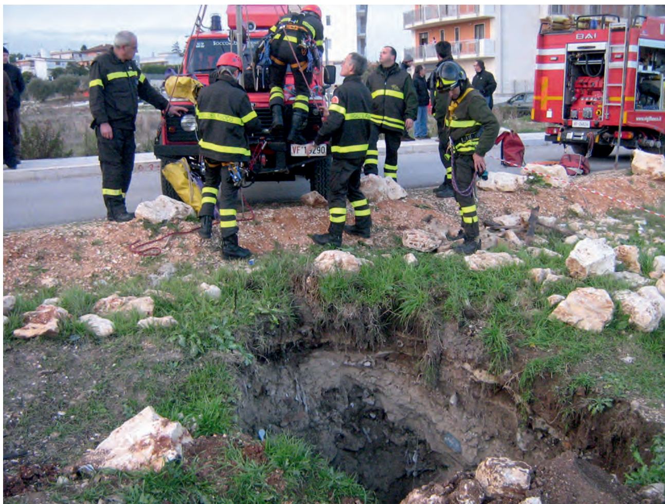
Fig. 2 - Sprofondamento verificatosi in via Fornaci il 2 dicembre 2008. – Sinkhole occurred at Fornaci street on December 2, 2008.
