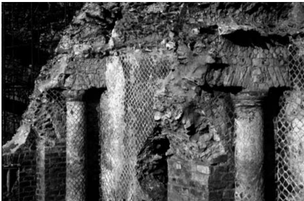
Fig. 6 – Barco Borghese, ambienti NN. 159-160: veduta in sequenza delle pareti nord decorate da semicolonne in muratura coronate da capitello dorico in tufo (foto: M. Valenti). – Barco Borghese, rooms nos. 159-160: view of north walls decorated by masonry semi-columns with tuffa doric capitals (photo: M. Valenti).
