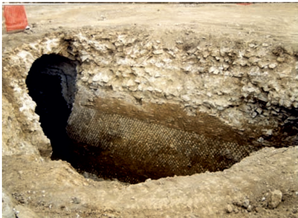
Fig. 17 – Barco Borghese, corridoio N. 95: strutture di rinforzo in opera mista (foto: M. Valentini).
