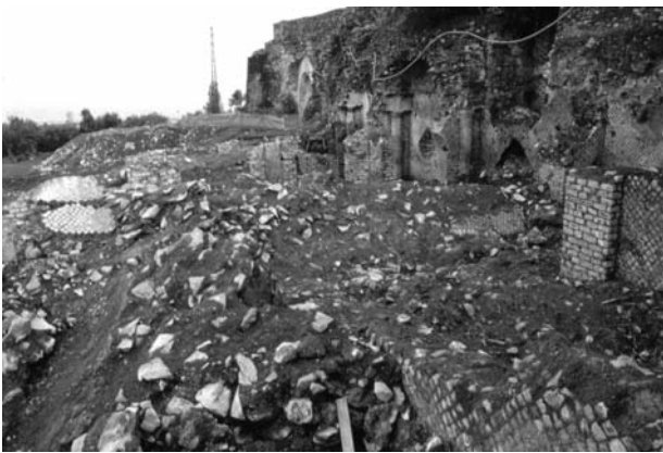
Fig. 7 – Barco Borghese, settore esterno occidentale: crolli monumentali rivelati dallo scavo archeologico nel settore più meridionale (foto: M. Valenti). – Barco Borghese, external view of the western area: monument collapses revealed by archaeological excavations in the southernmost sector (photo: M. Valenti).
