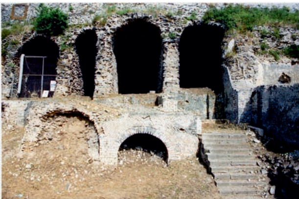
Fig. 12 – Barco Borghese, ambiente N. 191: scalinata e rampa di collegamento con il piano superiore delle sostruzioni (foto: M. Valenti).
