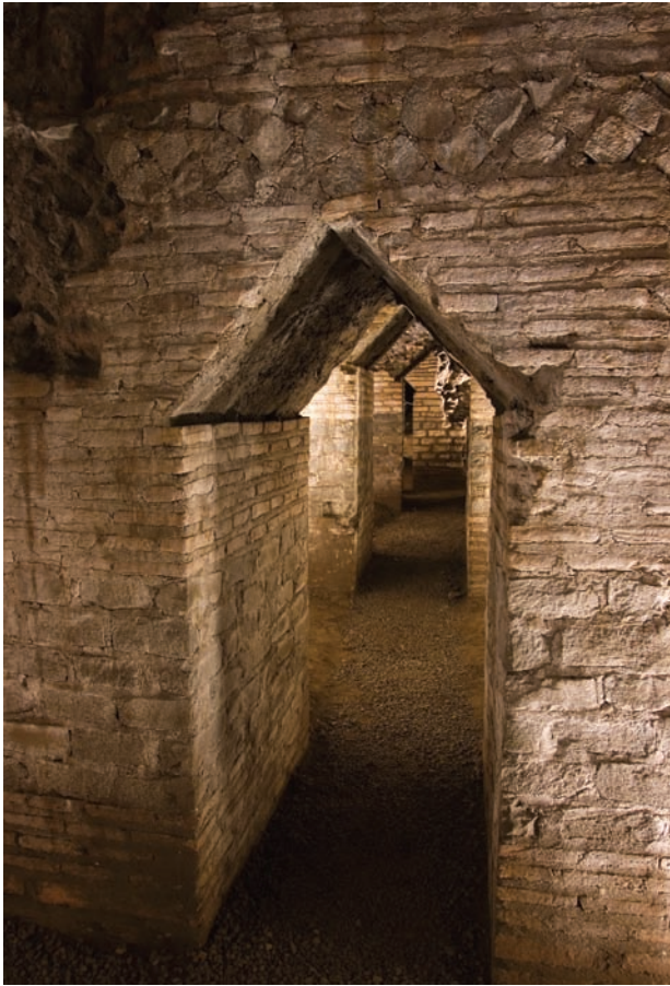
Fig. 16 – Barco Borghese, ambiente N. 117: sequenza prospettica dei varchi antichi alla base dei tramezzi murari in opera mista (foto Archivio fotografico Polo Museale Monte Porzio Catone). – Barco Borghese, room no. 117: perspective sequence of ancient passages at the base of partition walls in opus mixtum (photo: Archivio fotografico Polo Museale Monte Porzio Catone).
