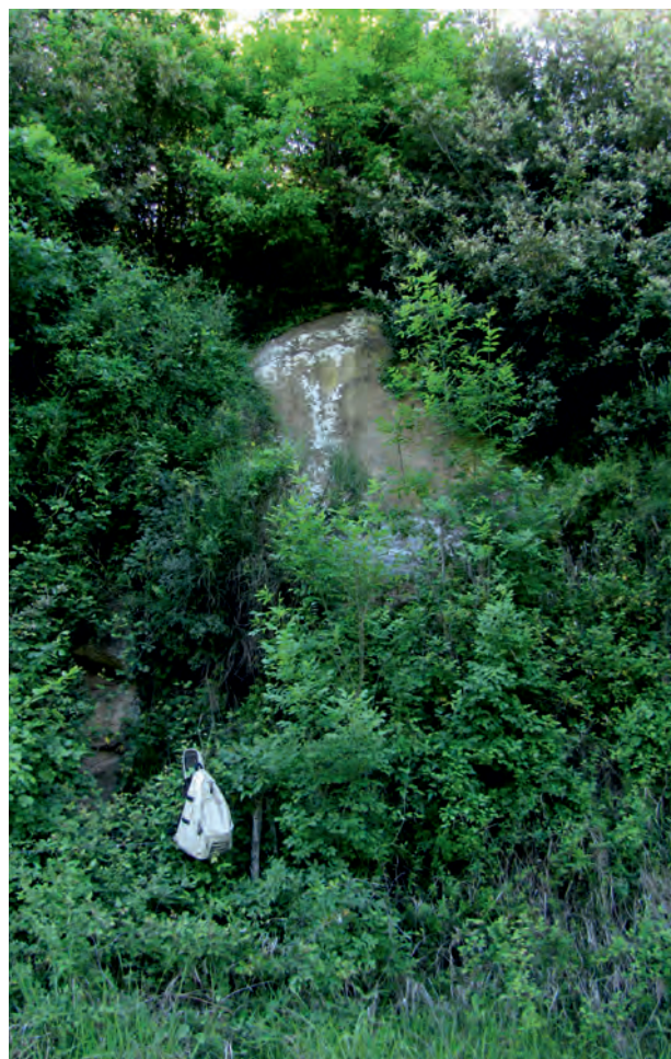
Fig. 6 – Particolare della scarpata incisa nei depositi piroclastici. - Detail of the slope engraved in the Pyroclastic deposits.
