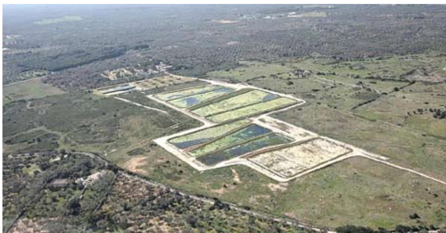
Figura 4 - Impianto di fitodepurazione di Melendugno (Le)
