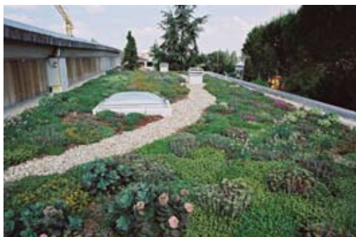
Figura 3 - Tetto Verde su copertura azienda Co.Pa.Ri. a Forlì (FC)
