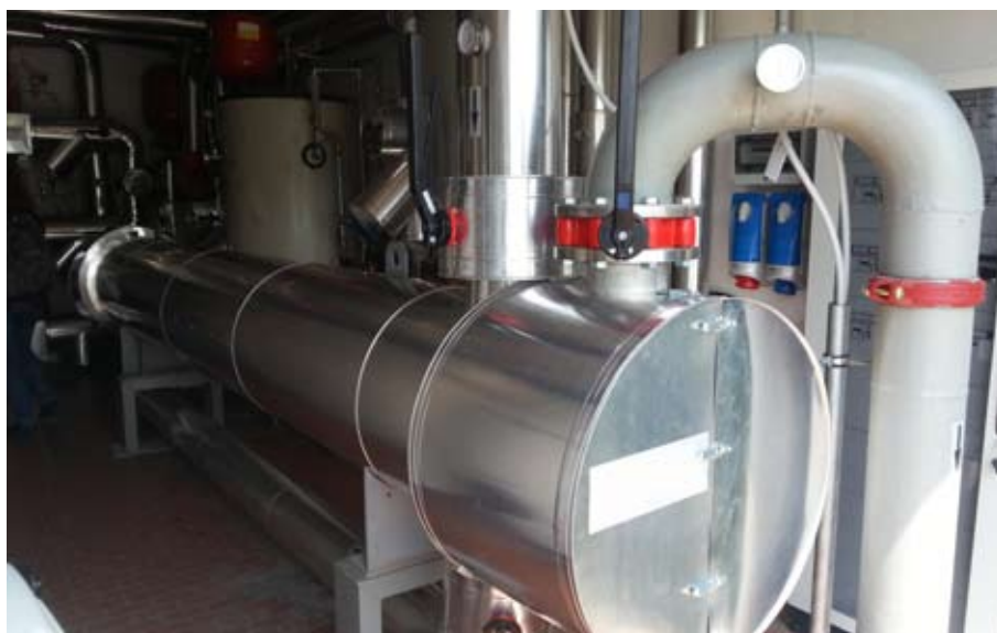
Figura 3 - Scambiatore di calore a fascio tubiero collocato presso il Depuratore di Nosedo, Milano
