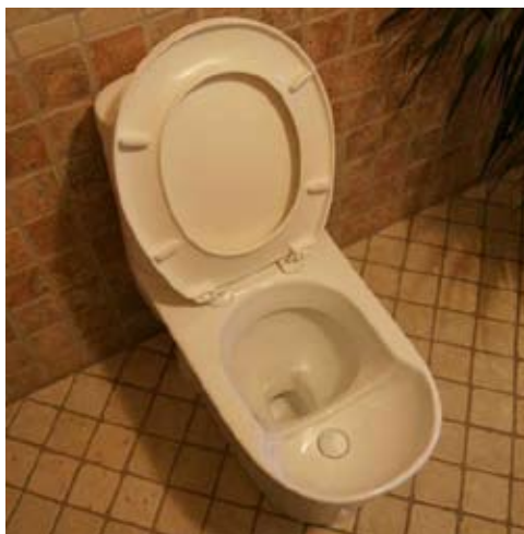
Figura 3 - Toilette con sistema di separazione
