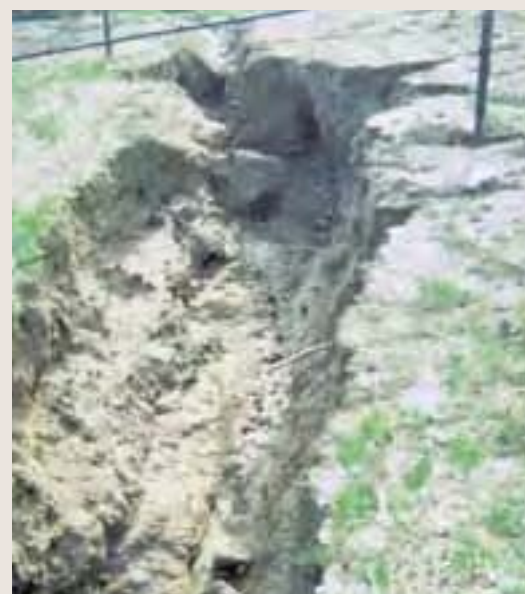
Fig. 3.12 - Erosione per burroni ( gully erosion ).
