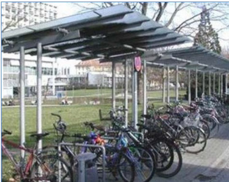
Infrastrutture per le biciclette all'Ospedale Universitario di Friburgo (Fonte Eltis 2012)
