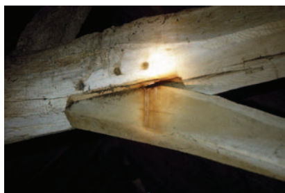
Figura 2.7 - Particolari delle congiunzioni di due travi in legno in un fienile col sistema tenone-mortasa, che forma una piccola cavità adatta al rifugio di chiroterteri (da Briggs, 2004).
