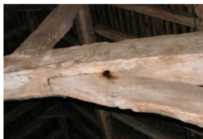
Figura 2.7 - Particolari delle congiunzioni di due travi in legno in un fienile col sistema tenone-mortasa, che forma una piccola cavità adatta al rifugio di chiroterteri (da Briggs, 2004).
