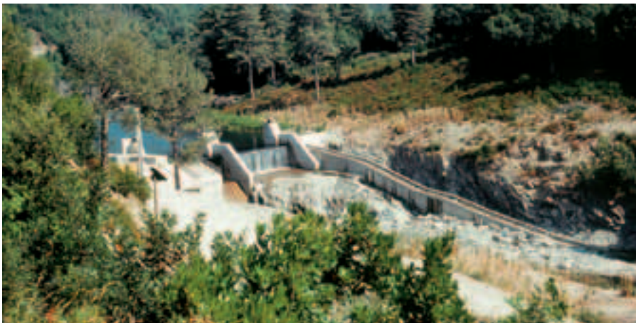
Figura 46 - Una scala di risalita realizzata in corrispondenza di un piccolo sbarramento di un corso d'acqua della Corsica (Francia); la sua funzione è probabilmente quella di favorire il raggiungimento delle aree di frega da parte della Trota macrostigma. Tali strutture rientrano nella più ampia categoria dei "passaggi per pesci", che possono essere costruiti in prossimità delle dighe e degli altri sbarramenti trasversali dei corsi d'acqua.
