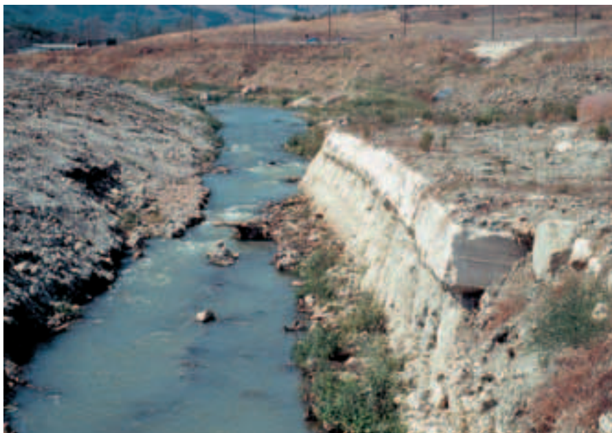
Figura 4 - Esempio di pesante alterazione morfologica di un corso d'acqua conseguente a lavori per la realizzazione di una strada (fiume Biferno, Basilicata, settembre 1998).
