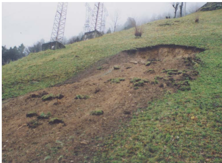
Figura 14.12 Frana presso Venturina (LI).
