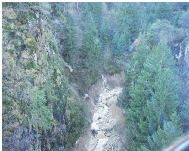
Figura 8.25 Parte media del torrente con segni tipici d'erosione profonda e laterale a causa di debris flow.
