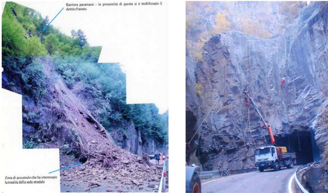
Figura 8.9 Interventi di disaggio e di difesa attiva e passiva.
