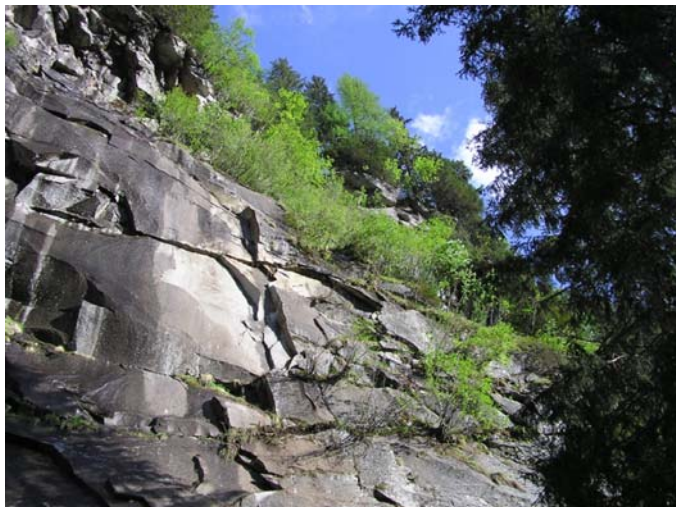
Figura 8.12 Nicchia di distacco.
