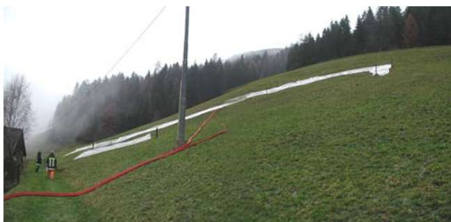
Figura 8.17 a) Panoramica del versante; b) Corpo di frana che ha coinvolto l'edificio adiacente il maso; c) Prime fasi d'intervento (teli impermeabili sulla nicchia di distacco e tubi drenanti nell'area di frana).
