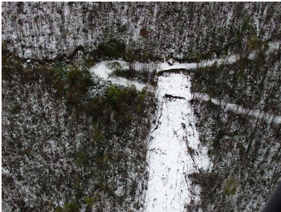
Figura 3.18 Scivolamento traslativo evolvente a colata innescatosi in corrispondenza di un tornante di una strada forestale, Cervinara (AV) 15/12/1999.
