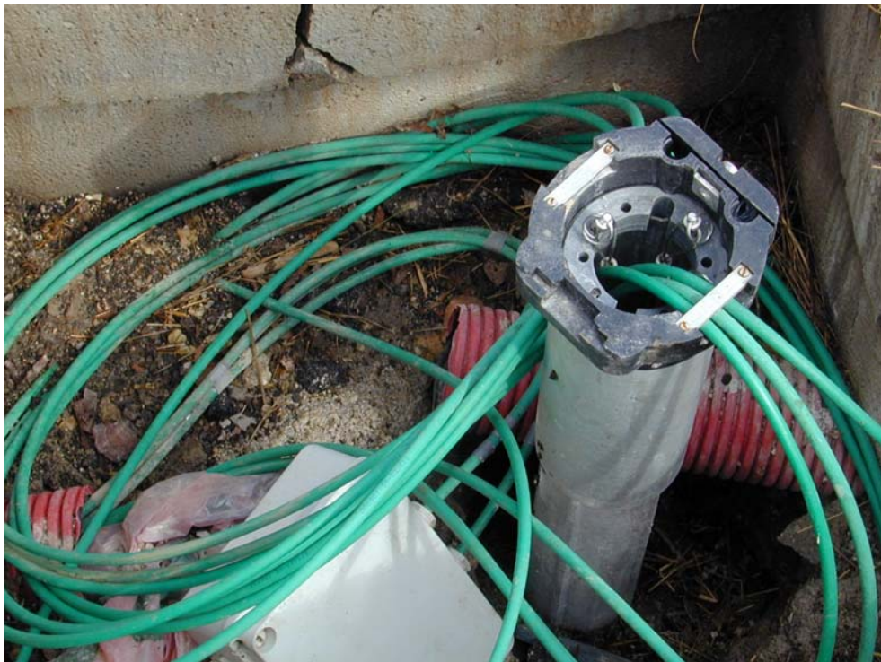
Figura 3.26 Inclino metro, frana di Perarolo (BL).
