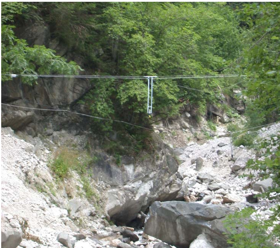
Figura 3.31 Ecometro per il sistema di allarme e monitoraggio del debris flow del T. Rudan, Vodo di Cadore (BL).
