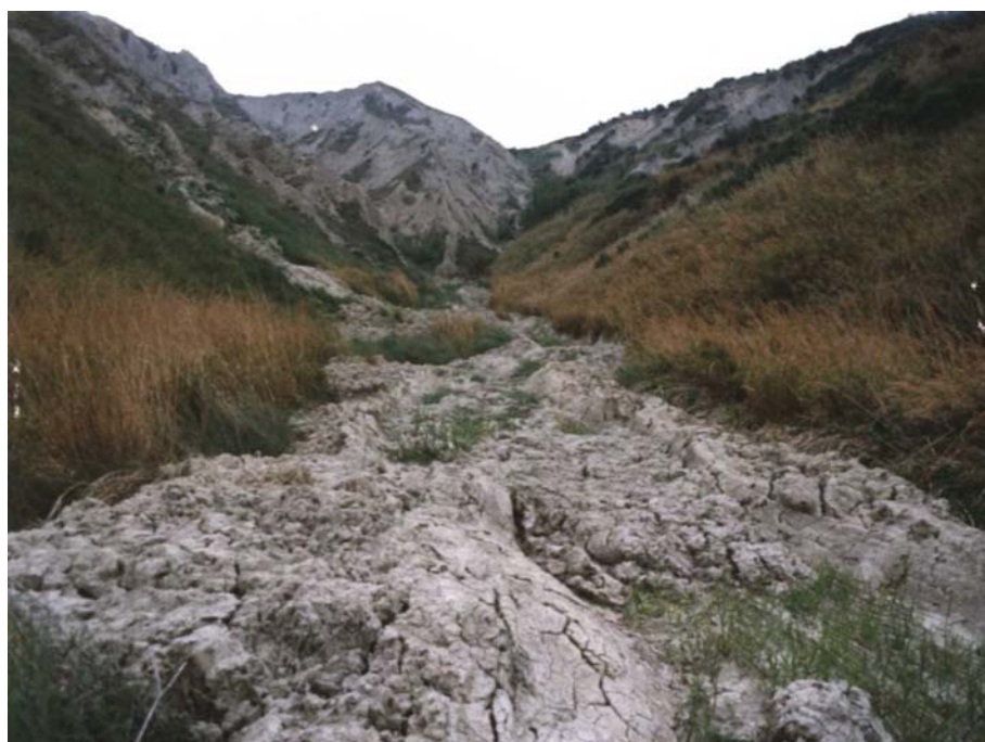
Figura 15.22 Mud flow in località Lignano in Teverina (TN).
