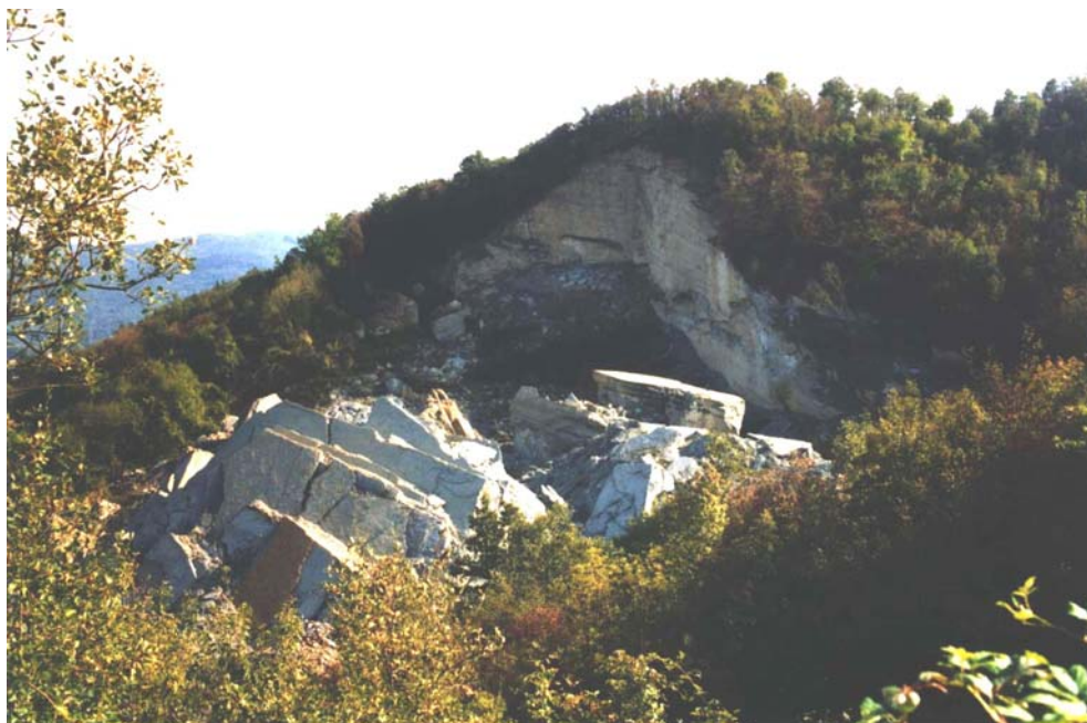
Figura 12.10 Frana in Comune di Cengio.
