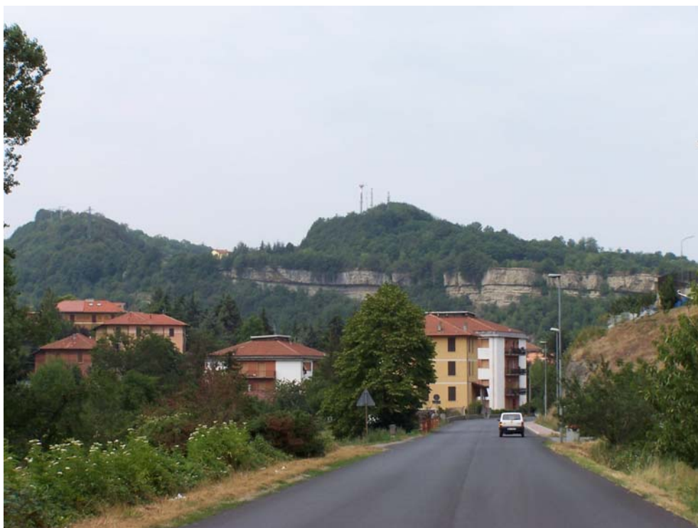
Figura 12.11 Frana in Comune di Cairo Montenotte.
