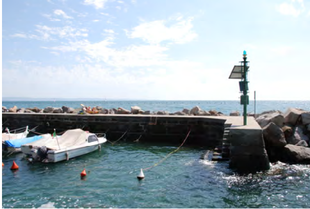
Figura 6.5 – Porticciolo di Filtri, stazione 1165, comune di Duino-Aurisina.
