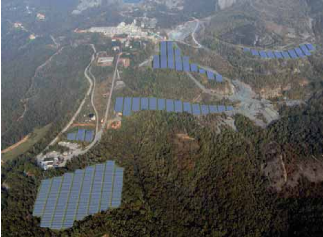
Figura 9. Progetto campi fotovoltaici
