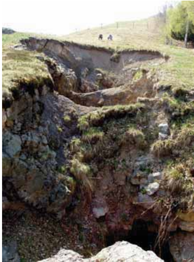
Figura 12. Collapsi recenti del tetto di vuoti di coltivazione mineraria vicini alla superficie. Miniera Monte Trevasco.
