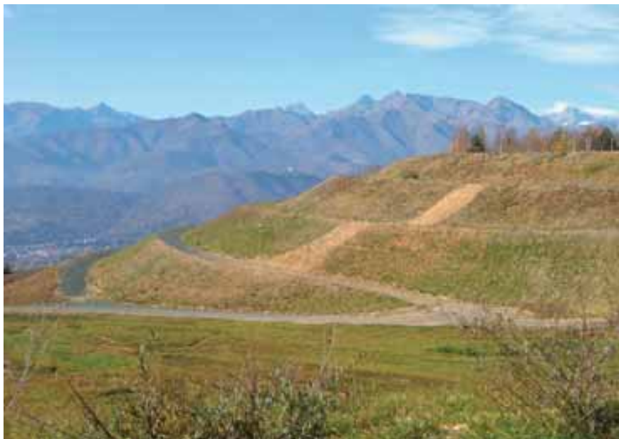
Figura 4. - Messa in sicurezza idrogeologica con sistemazione dei versanti (Archivio RSA srl, 2007)
