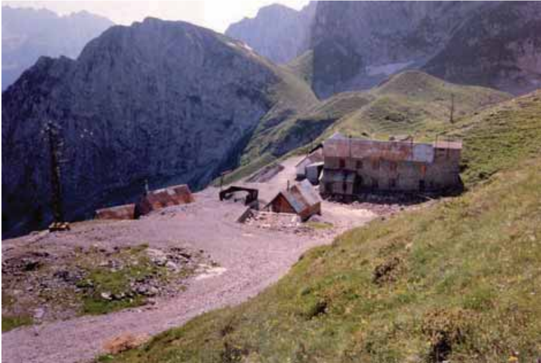
Figura 4. Miniera del Laghetto di Polzone, impianti esterni.
