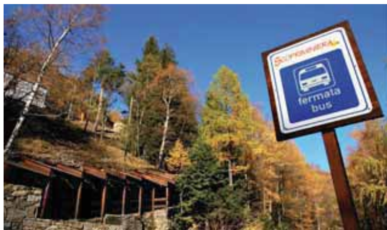
Figura 13. Il percorso coperto di accesso alla biglietteria
