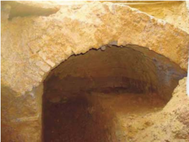
Fig. 3 - Visuale dell'ipogeo scavato in sabbie gialle della formazione di Monte Mario. (MTM). - View of the hypogeum excavated in yellow sands of the Monte Mario formation (MTM).
