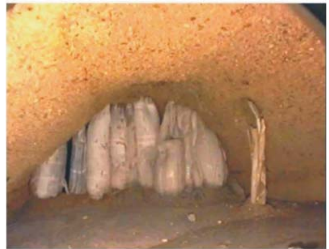
Fig. 26 - Isolamento di una zona ipogea con micropali e sacchi obturatori per il successivo riempimento con miscele idonee. - Insulation of an underground area with micropiles and obturator bags for subsequent filling with suitable mixtures.
