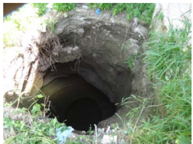
Fig. 4 - Tipica manifestazione di Sinkhole antropogenico. - Typical anthropogenic Sinkhole manifestation.
