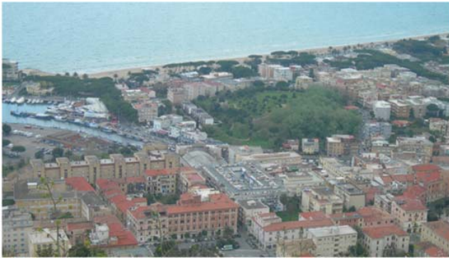
Fig.1 - Vista dall'alto dell'area investigata dove si identifica nettamente l'area del Montuno o Montone.
