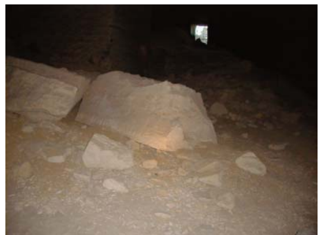
Fig. 28 - Esempio di crollo di soletta in ex cava di Pietra da Cantoni. - Underground tunnel cburning in a Pietra da Cantoni quarry.
