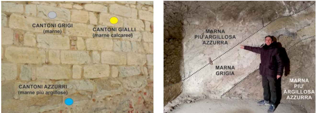
Fig. 15 - a) Treville, muro con diverse tipologie di cantoni: gialli (marne calcaree), grigi (marne) e azzurri (marne più argillose). b) Treville, cantina di Casa Devasini: strato marnoso grigio tra due strati di marna più argillosa azzurra.
