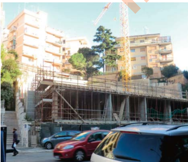
Fig. 10 - Visuale successiva alla realizzazione del parcheggio. - Post-construction view.
