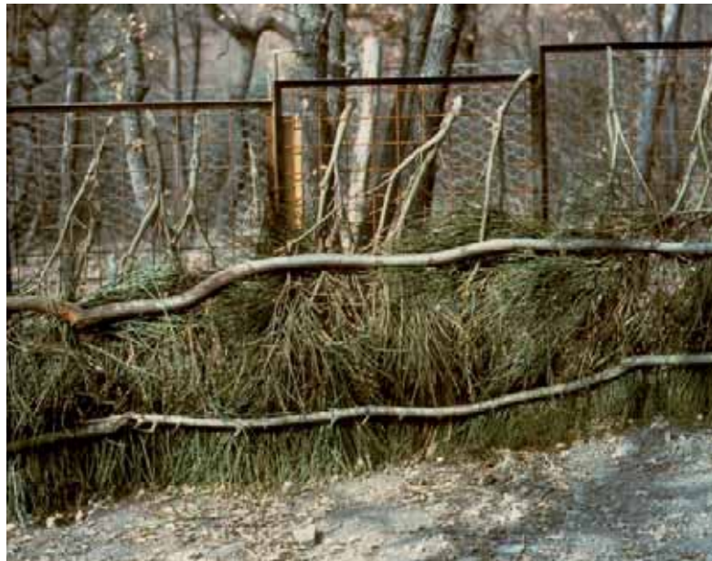
Figura 4 – Rivestimento del chiusino con fascine di ginestra.
