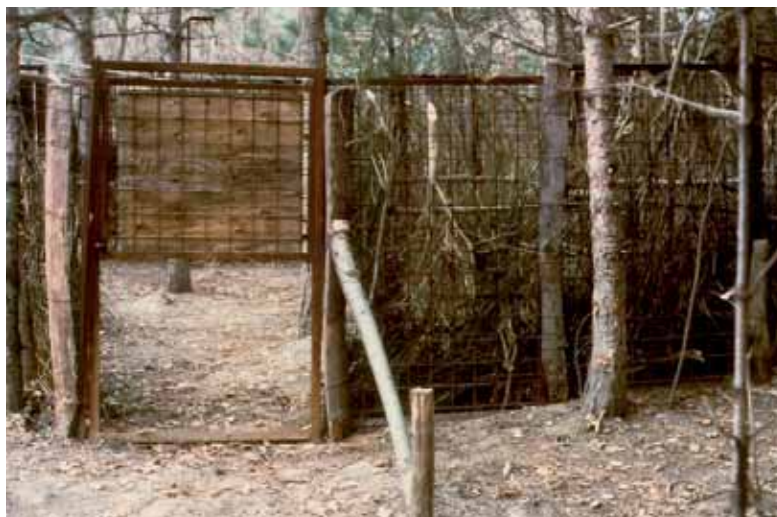
Figura 5 – Ancoraggio dei pannelli agli alberi circostanti.
