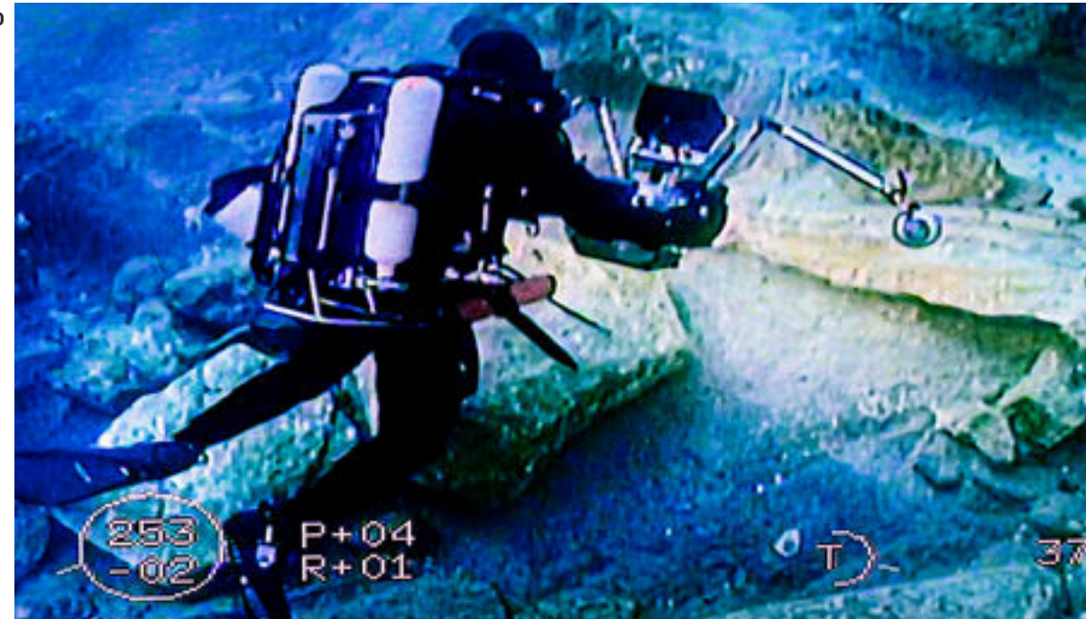
29, 30 Il controllo delle operazioni di ripristino è stato realizzato con l'impiego di robot filoguidati (ROV - Remotely Operative Vehicle) e di operatori subacquei.
