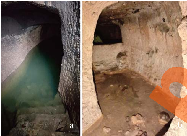
Fig. 12 - a) Vasca per la raccolta delle acque da cui si accede attraverso una scala, oggi sommersa; b) cunicolo presente sotto via della Collegiata.
