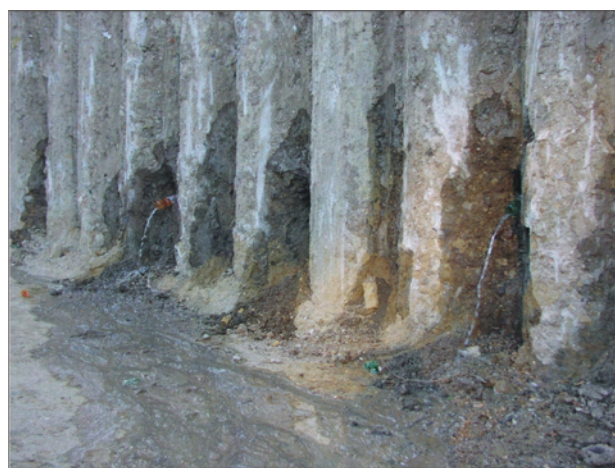
Fig.7 - La perdita della condotta idrica verificatasi alle spalle della paratia ha prodotto un innalzamento della falda con conseguente rapido aumento delle deformazioni in atto.
