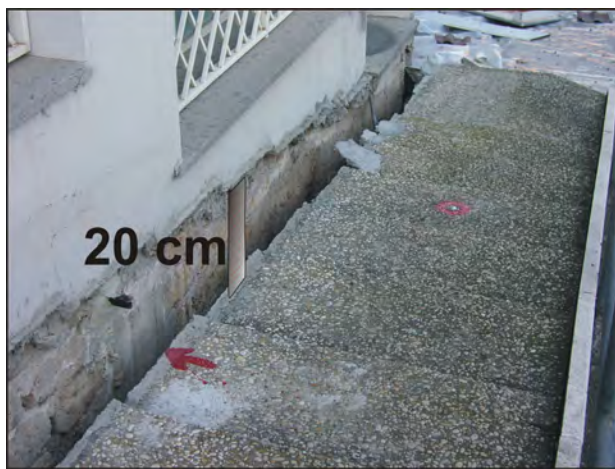
Fig. 2 - Segni di instabilità su strutture limitrofe a seguito degli scavi per la costruzione del parcheggio.
